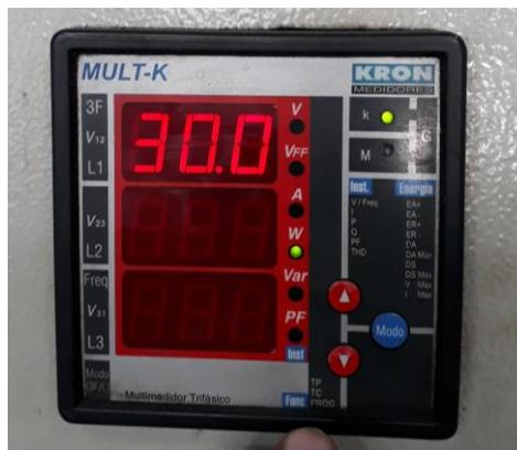
Figura 4.6. Painel de controle do banco de cargas.
