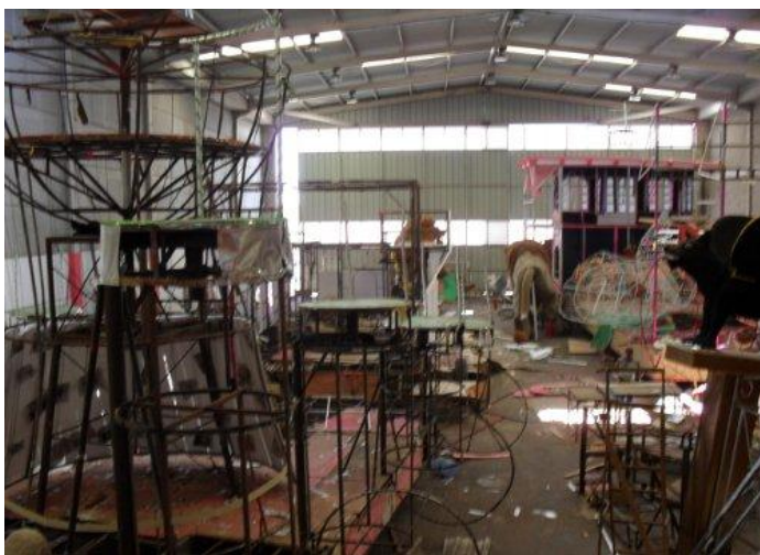
FIGURA 16: Barracão em fase inicial
