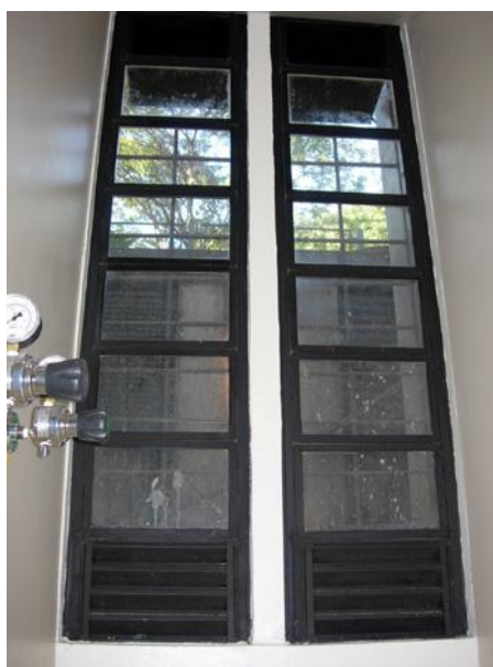
FIGURA A4.7: Sistema de exaustão natural.
