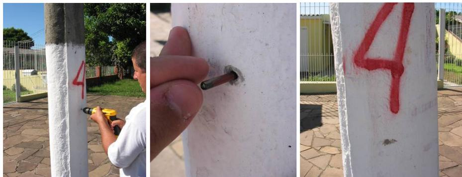
Figura 46 – Aplicação dos TAGs em postes de concreto.
