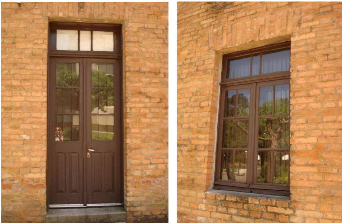
Figuras 138 e 139: Detalhe das esquadrias originais e verga reta de tijolos na fachada frontal das casas de terceira ordem. Ao contrário das moradias de primeira e segunda ordem, têm a porta frontal voltada para o logradouro.
