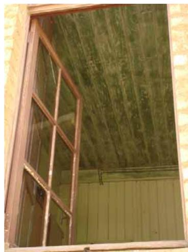
Figura 205: Revestimentos internos em madeira
