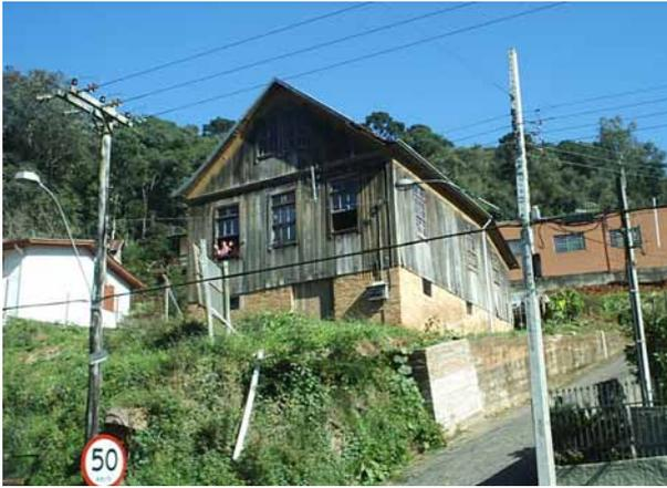
Figura 48: No caso desta casa construída em Galópolis, no aproveitamento do declive, foi construído o porão; porém, nesta versão, de tijolos ao invés de pedras.
