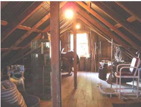
Figura 55: Sótão sem divisórias internas e com janelas nas empenas, o que garantia a ventilação cruzada para secagem dos grãos que ali eram estocados.
