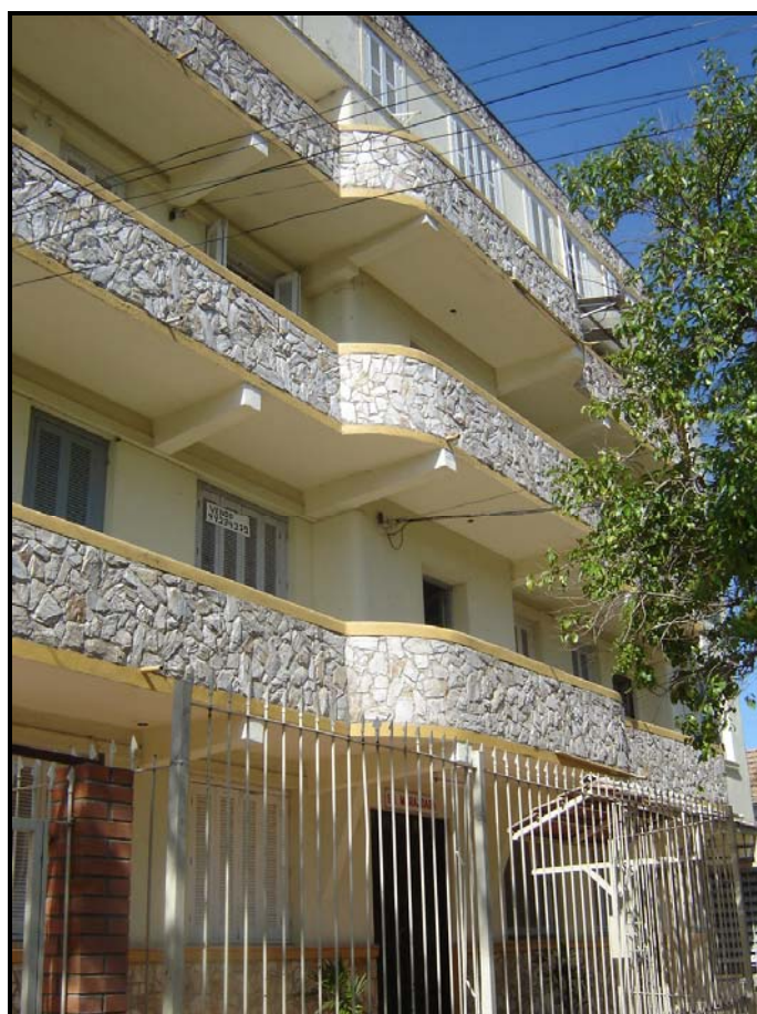
Figura 130 - Foto atual (agosto de 2010) do edifício Tamoio, atualmente Marajoara. Percebem-se diversas alterações, inclusive o acréscimo de um pavimento. Fonte: Fotografia da autora.
