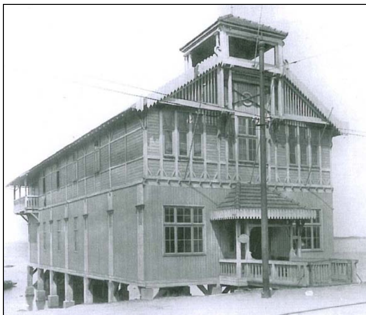
Figura 165 - Clube de Regatas Almirante Tamandaré. Fotografia de 1916, de Theo Wiederspahn, autor do projeto e da construção. Fonte: WEIMER,2009,op.cit.,p. 77.
