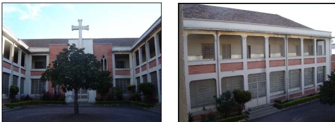
Figura 154 - Fotografia atual (janeiro de 2009) da Creche Nossa Senhora dos Navegantes, situada na avenida Sertório.
