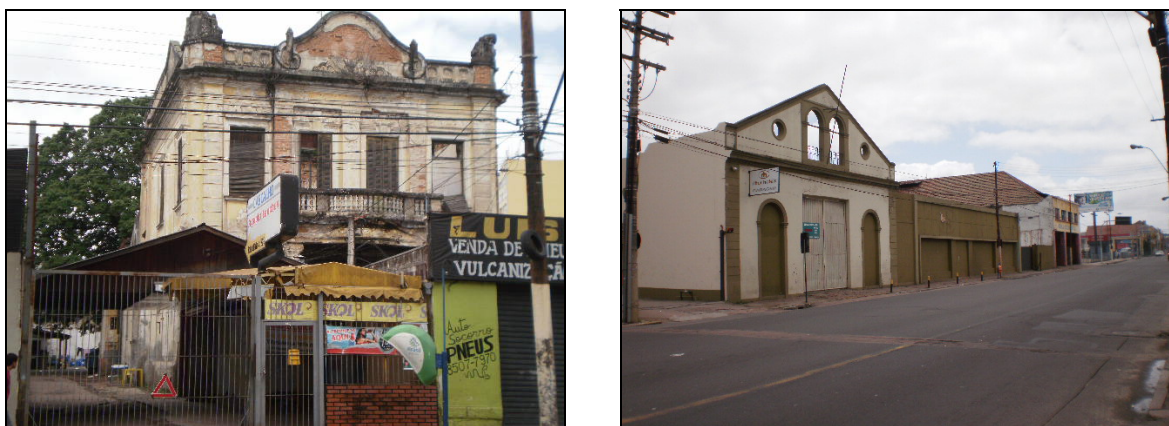
Figura 178 - Trecho atual(janeiro de 2009) da Voluntários da Pátria, nas proximidades da Estação Rodoviária, onde antigas edificações residenciais, de armazéns e depósitos hoje estão decadentes. Fonte: Foto da autora.
