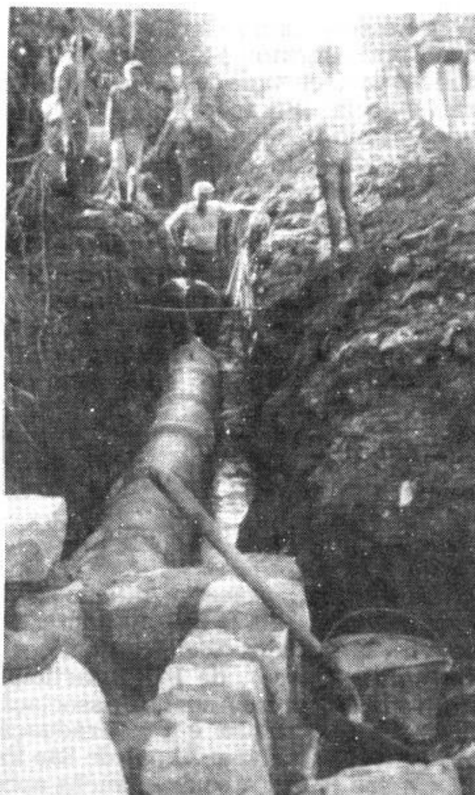
Redes de esgoto
