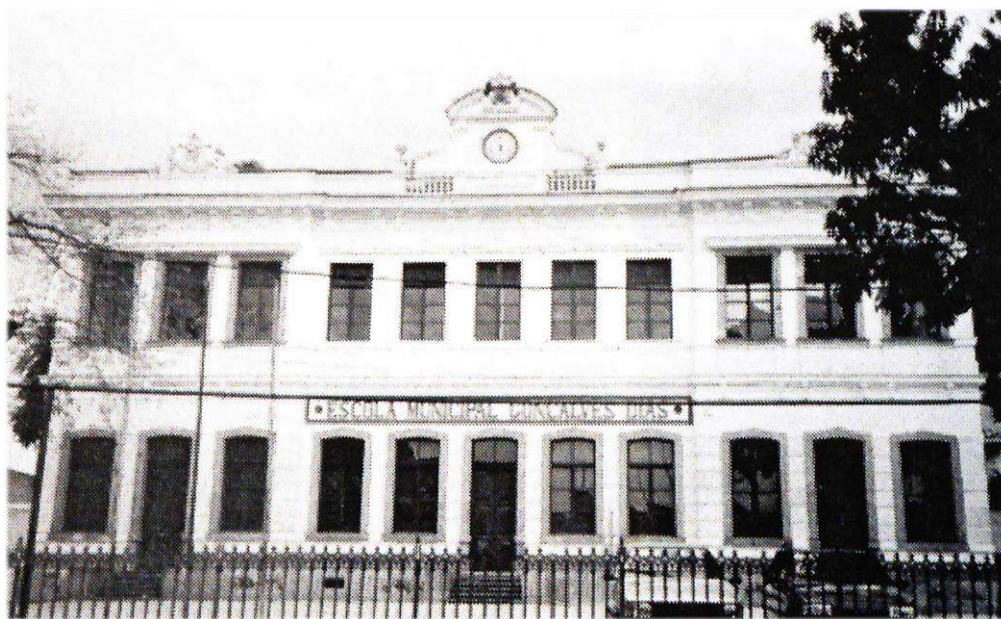
Figura 21: Fachada frontal da escola Gonçalves Dias – Rio de Janeiro
