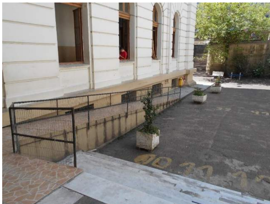
Figura 80: Rampa de acessibilidade do Colégio Estadual Paula Soares (2016)
