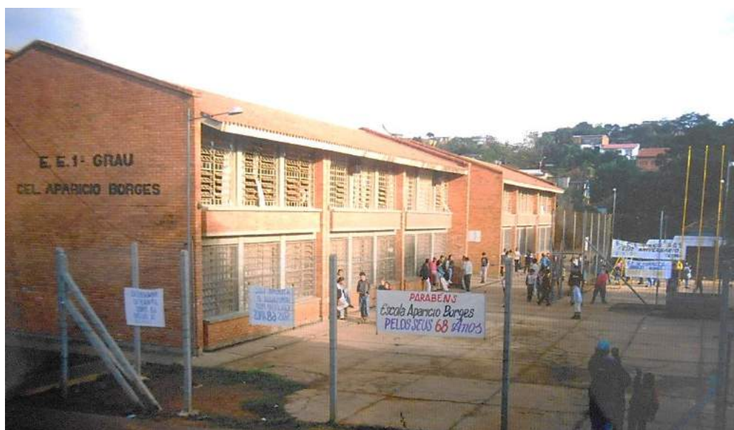
Figura 97: Novo edifício da Escola Estadual Aparício Borges (década de 1990)
