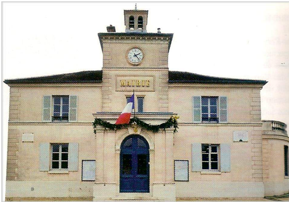
Figura 10: Mairie-École de Marnes-La-Coquette (1846-1849). Arquiteto: Hippolyte Blondel
