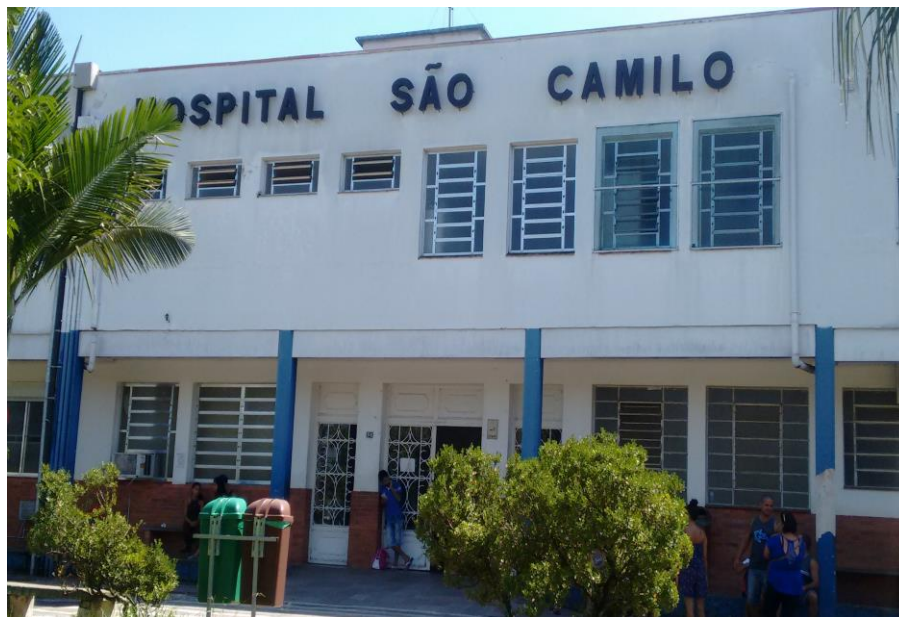
Figura 2 – Hospital São Camilo
