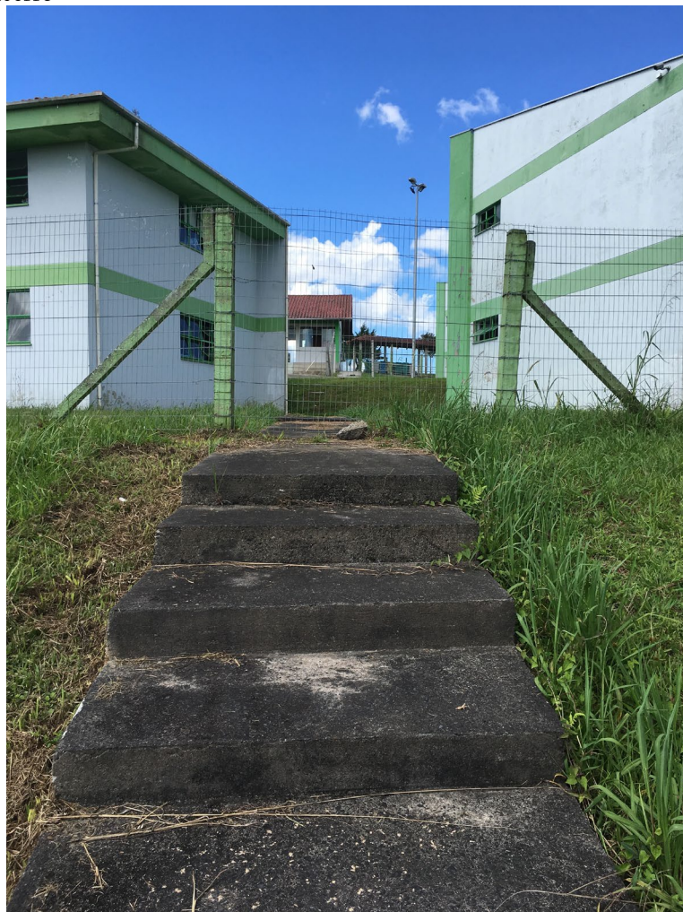
Figura 35 – Caminho cortado pela cerca construída ao redor do alojamento masculino na gestão de S2. Ao fundo, a guarita de acesso
