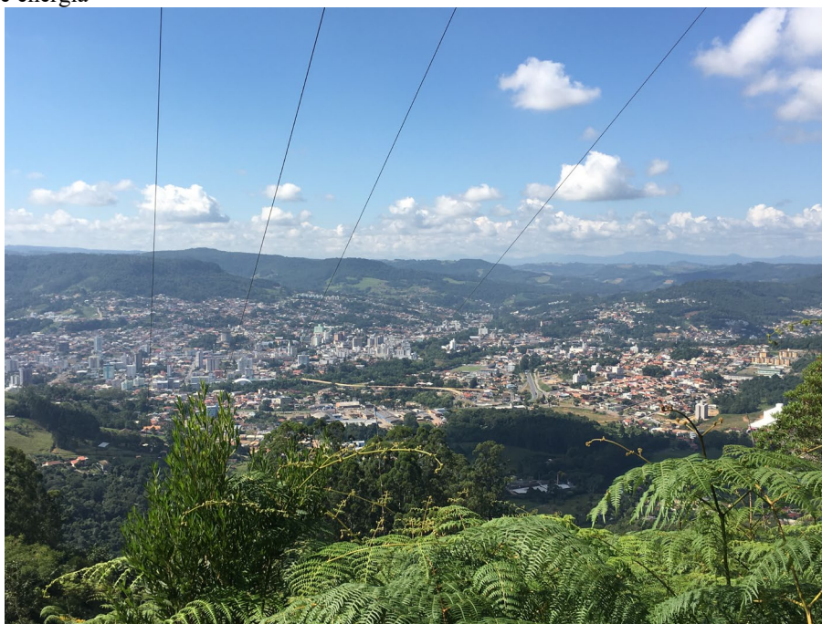
Figura 11 – Cidade de Rio do Sul vista da unidade sede agrária do IFC, com destaque para as linhas de transmissão de energia
