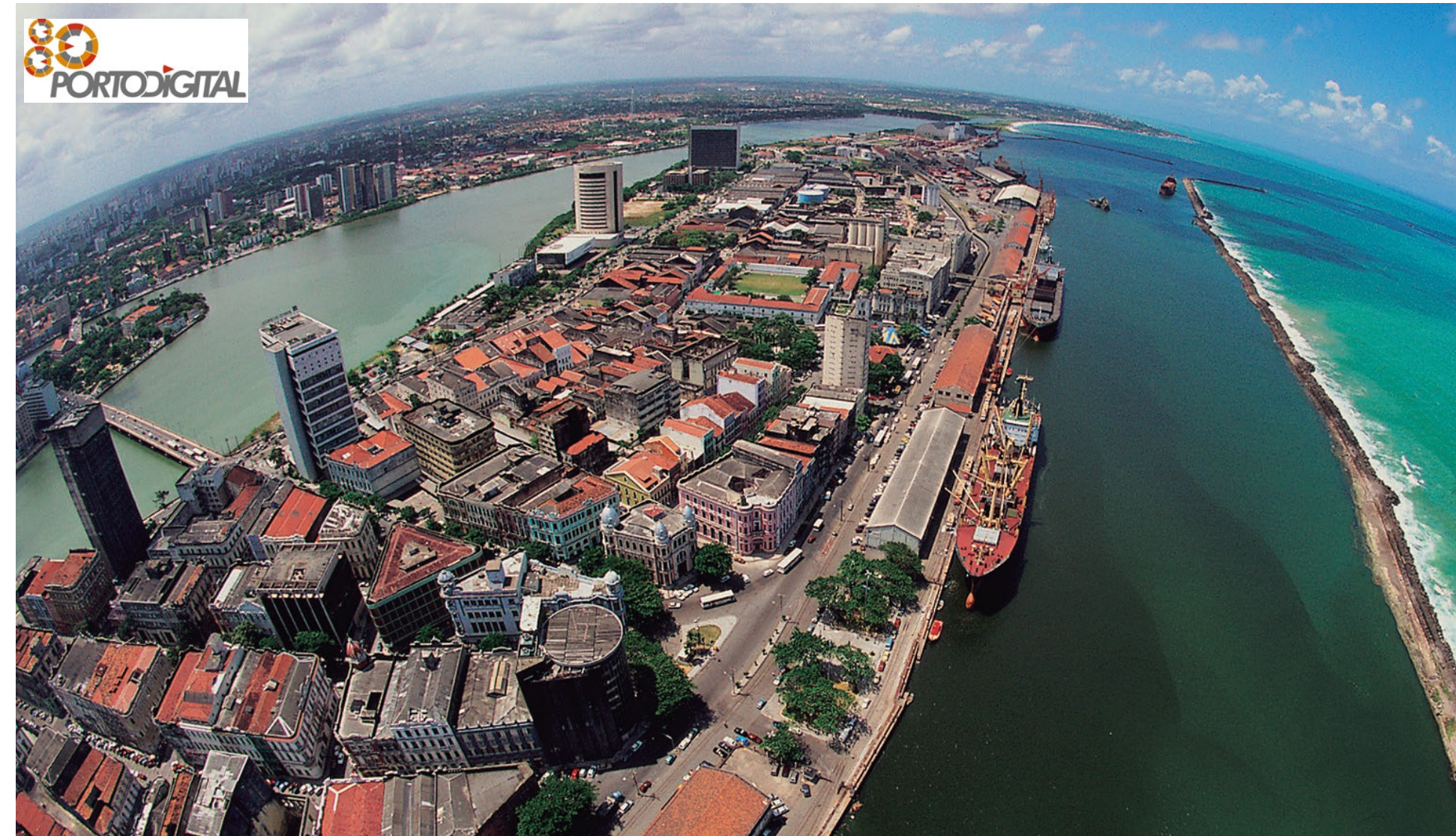
Instalado no Bairro do Recife, em Pernambuco, o Porto Digital revitalizou área urbana do centro antigo da cidade. Vencedor do Prêmio Anprotec, na categoria Parque Científico e Tecnológico: 2007, 2011 e 2015
