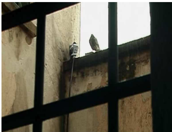
Figura 25: Janela com grades.
