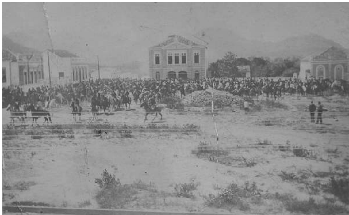
5. Praça Saldanha Marinho em construção. Ao fundo o Teatro Treze de Maio. Podem-se notar os fios e postes de energia elétrica, mais um elemento do Progresso em Santa Maria. Provável ano da foto: 1899. Acervo fotográfico do ACMEC.
