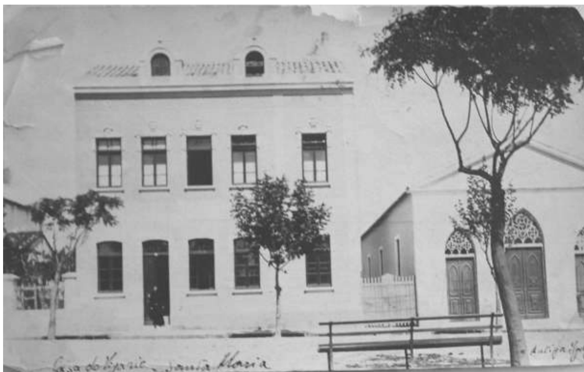
7. À direita, a Capela do Divino Espírito Santo, construída entre 1882 e 1887, símbolo da religiosidade de origem açoriana, além de ser uma marca do catolicismo leigo que viria a sucumbir com a chegada de um novo modelo de religião. À esquerda, a casa canônica e residência do vigário, edificada décadas depois. O templo do Divino foi demolido no final da década de 1930. Foto do AHPNSC.
