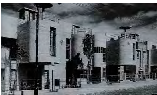
FIGURA 115: Conjunto de Casas Alameda Lorena
