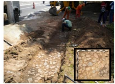
Figura 03 - Foto geral do calçamento de pedras irregulares evidenciado do trecho extinto da Rua Vasco Alves.
