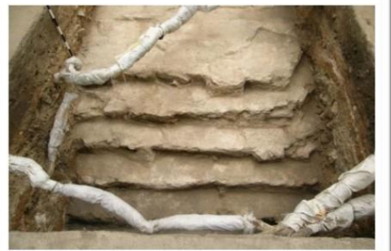
Figura 09 - Fotografia de topo da escadaria. Originalmente os degraus eram revestidos com lajes de arenito.
