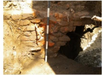
Figura 03 - Detalhe da mureta de tijolos maciços.
