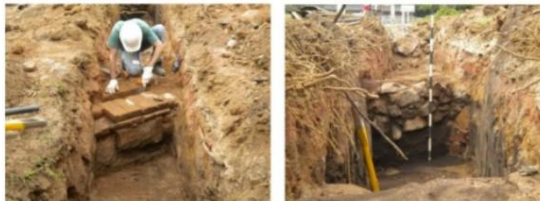
Figura 10 - Estrutura de alvenaria de tijolos com fundação de pedras.
