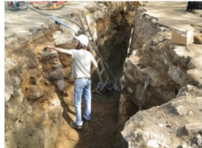
Figura 06 - Estruturas paralelas de alvenaria de pedras e tijolos evidenciadas sobre os vestígios da linha de bonde.
