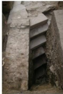
Figuras 10 e 11 - Degraus da escadaria junto ao muro do cais, onde encontram-se preservados ainda com o revestimento de lajes de arenito.
