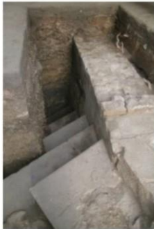
Figuras 10 e 11 - Degraus da escadaria junto ao muro do cais, onde encontram-se preservados ainda com o revestimento de lajes de arenito.
