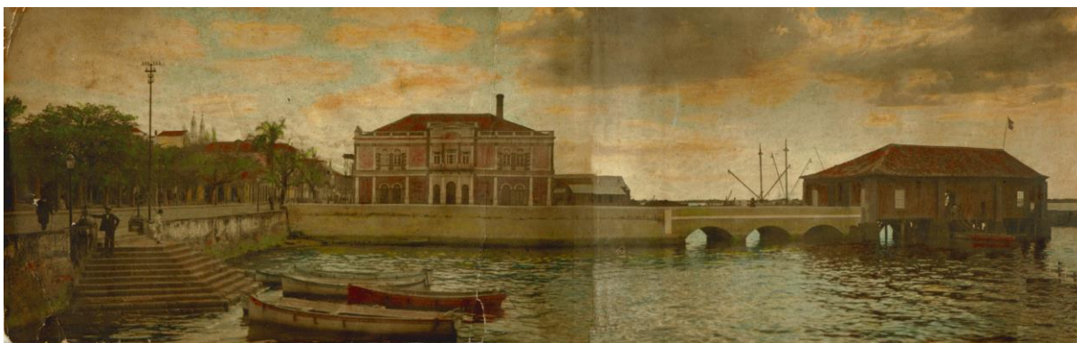
Figura 32 - Cais da Praça da Alfândega em 1900. O trapiche foi construído no início do século XIX, sofrendo algumas alterações e reformas ao longo do século. 226
