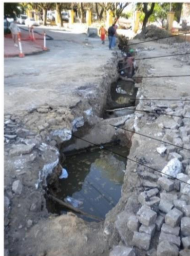
Figura 08 - Projeção do cais de pedras de arenito evidenciado junto a Rua dos Andradas.
