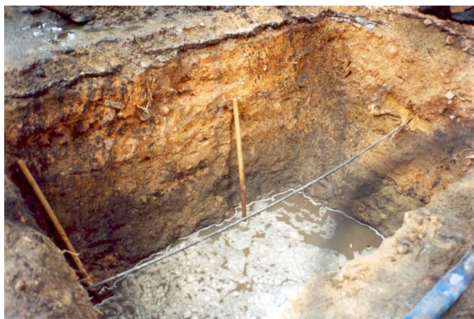
Figura 10 – Fotografia geral da sondagem 01 45 .
