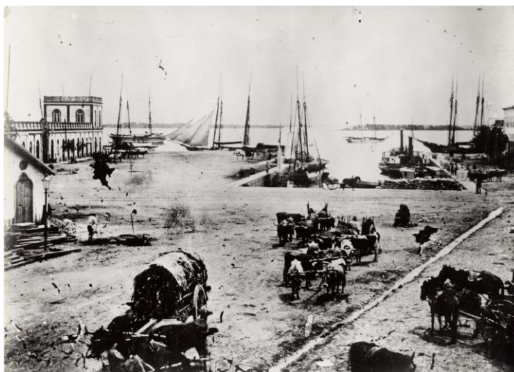
Figura 41 - Doca das Frutas, vista a partir da Rua de Bragança (atual Marechal Floriano); à esquerda, em segundo plano, o atual Mercado Público, à época, recém-construído. 326
