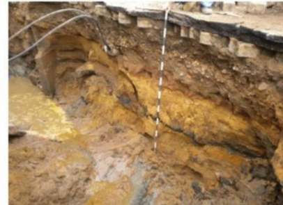
Figura 09 - Camadas de areia da praia junto a estrutura do cais.
