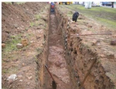
Figura 05 - Foto geral da vala, em primeiro plano vestígios de parede.
