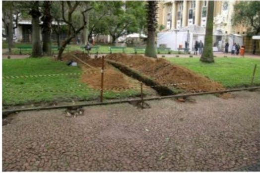
Figura 01 - Fotografia geral da escavação da trincheira tirada de leste para oeste.
