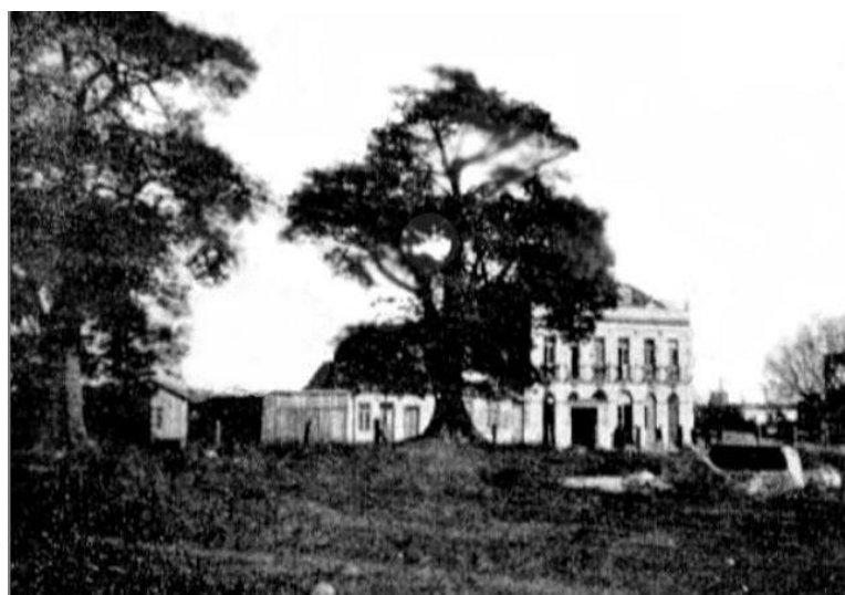
Figura 48 - Praça da Harmonia e edificações junto à Rua Vasco Alves 393 .
