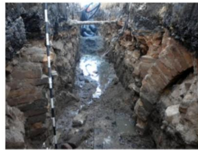
Figura 02 - Estrutura em arco construída sobre a margem.
