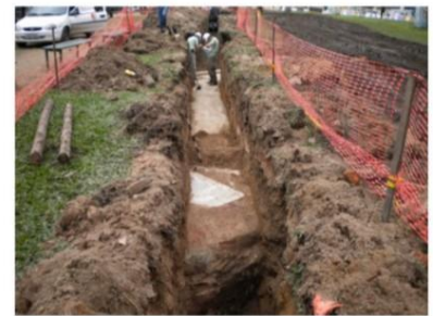
Figura 06 - Vestígios de edificação existente no pátio da antiga Casa de Correção.
