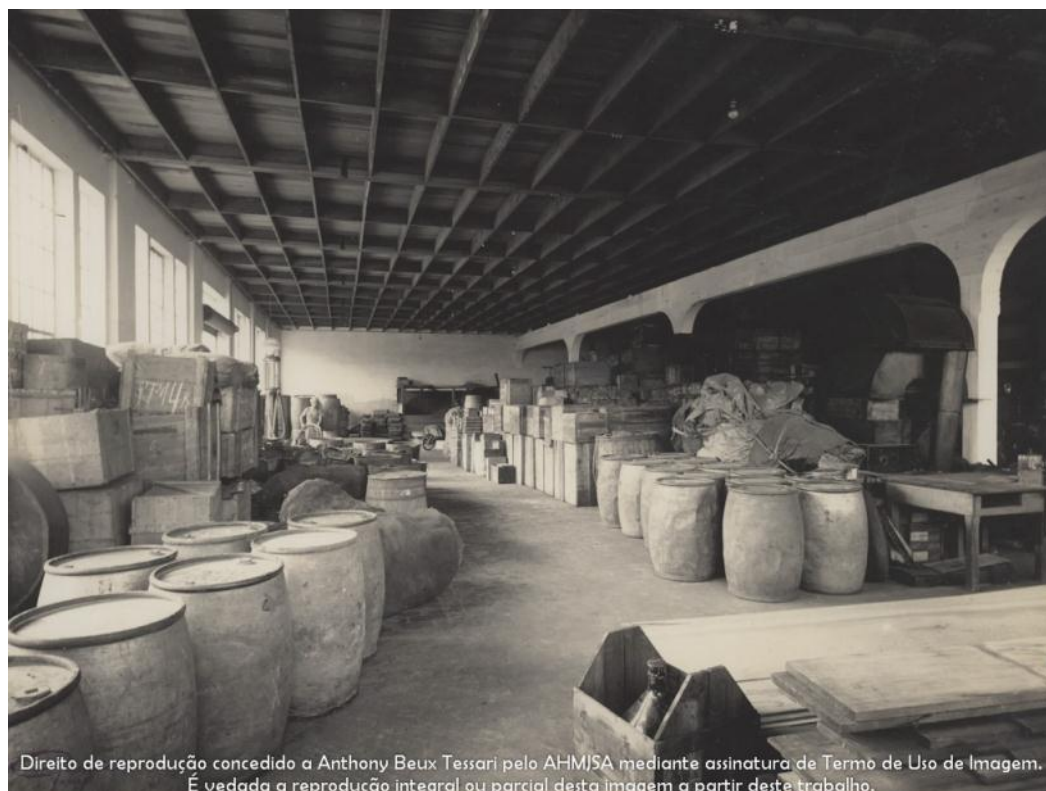
105 – Ano de 1940 – O depósito do Almojarifado.
