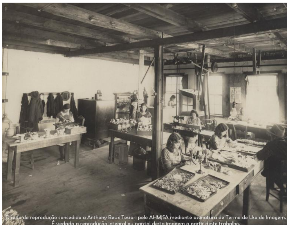
057 – Ano de 1925 – Vista da estufa e vernização.
