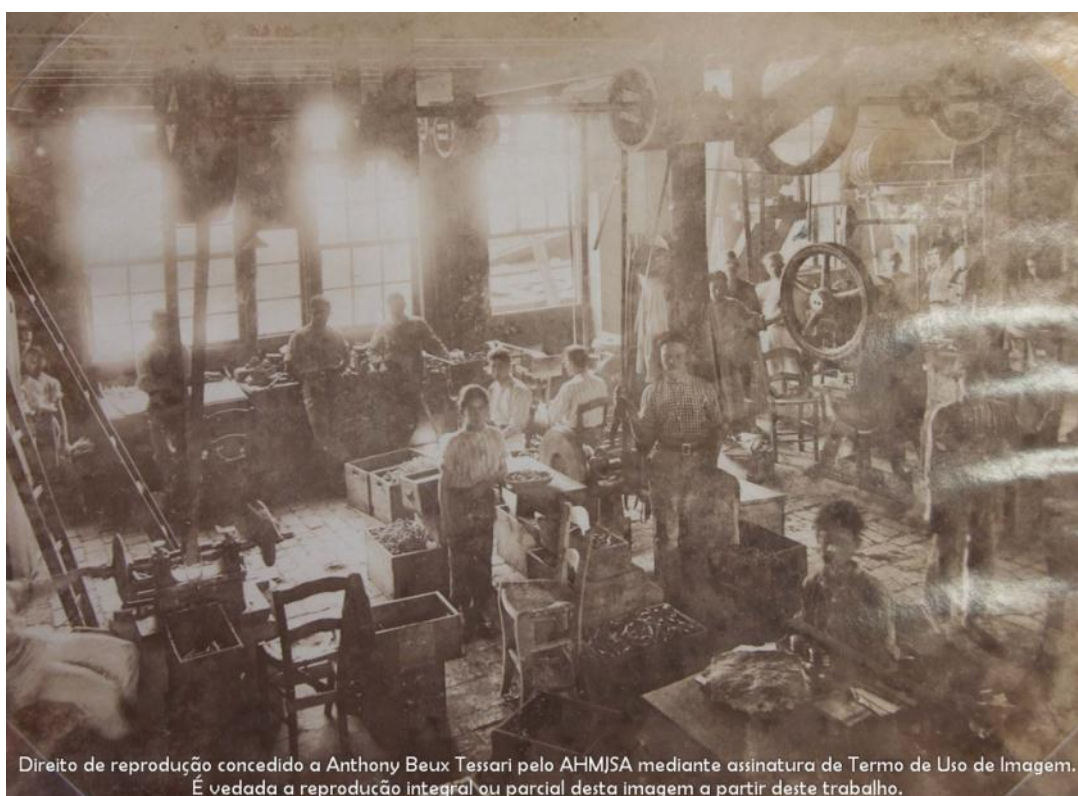
038 – Ano de 1922 – Limagem de artigos fundidos, prensas e esmerilhação.
