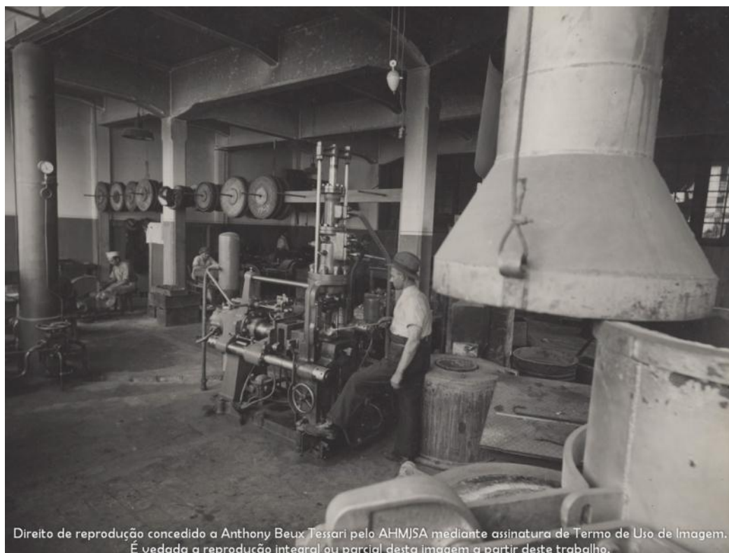
107 – Ano de 1940 –Fundição de metal à jacto (Spritz-guss).
