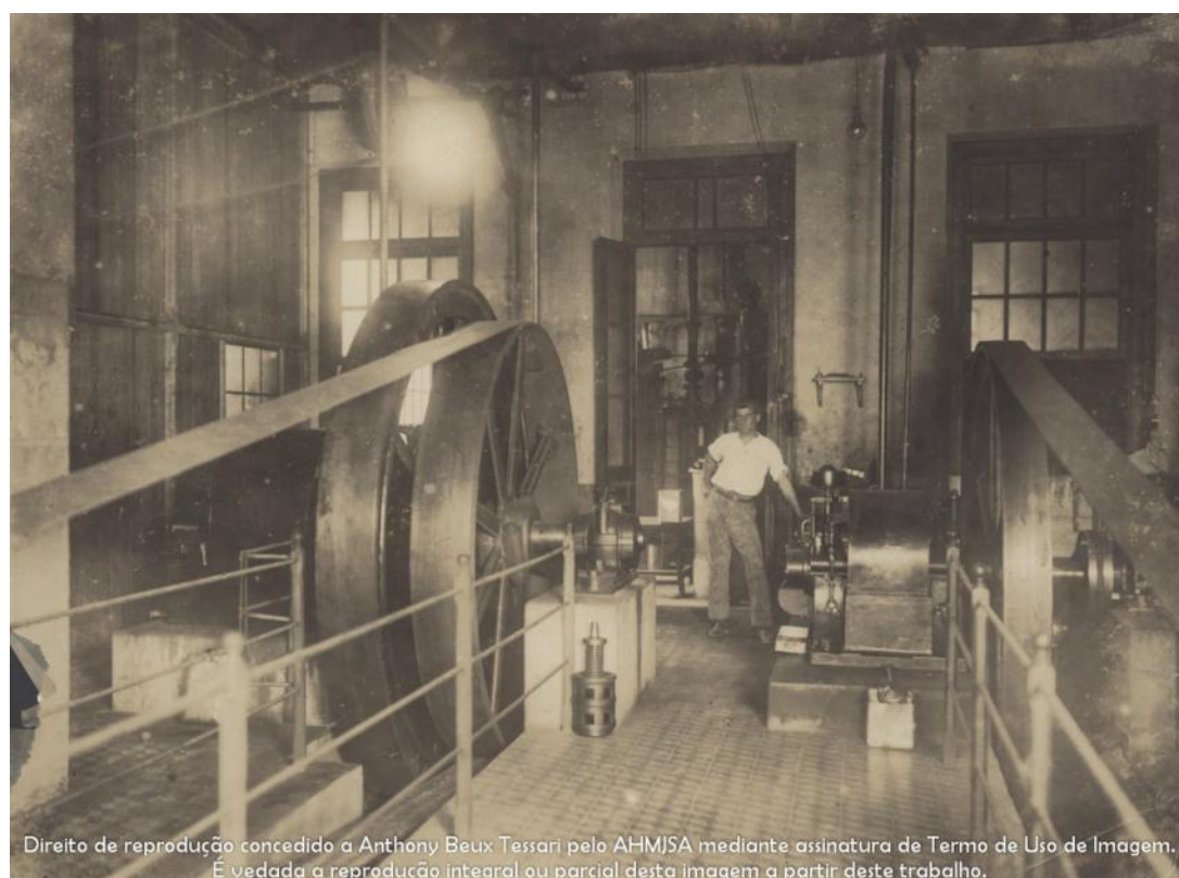
034 – Ano de 1922 – Usina a gaz pobre: os motores.
