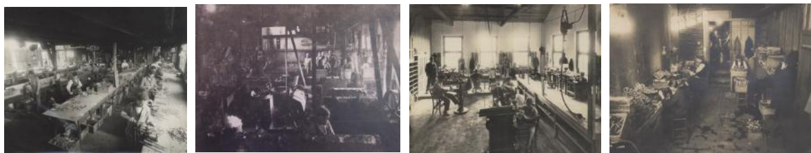
Fotos 61, 62, 64 e 65 – “Ano de 1925 – Outro aspecto da secção de limagem dos artigos fundidos e chapas para serigotes.” (extrema-esquerda). “Secção de tambores e banho de níquel. Aqui aparece também o sr. Abramo Eberle.” (centro-esquerda). “Gravação.” (centro-direita). “Soldação dos artigos de chapa.” (extrema-direita). Autorias desconhecidas (provavelmente Studio Geremia). Provas em papel, 18x24cm e 24x30cm.
