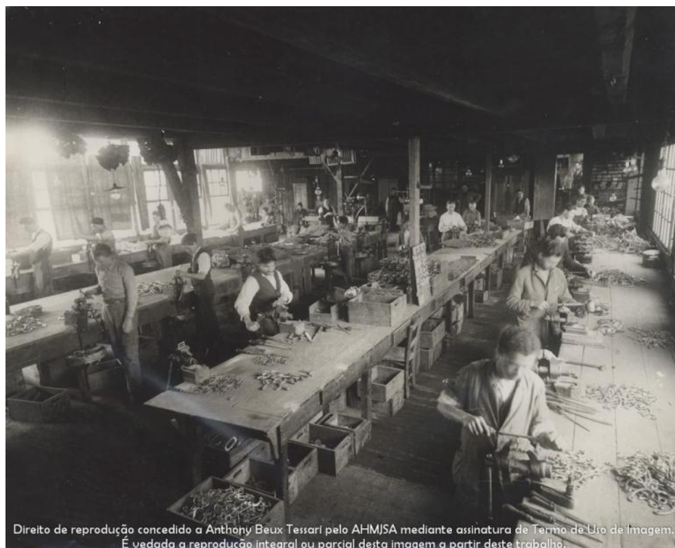
061 – Ano de 1925 – Outro aspecto da secção de limagem dos artigos fundidos e chapas para serigotes.
