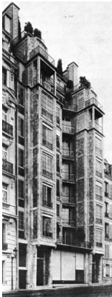
Imagem 13 – Prédio na Rua Franklin, Paris (1902-1903) – Auguste Perret. Fonte: GIEDION, 2005, op. cit., p.356.
