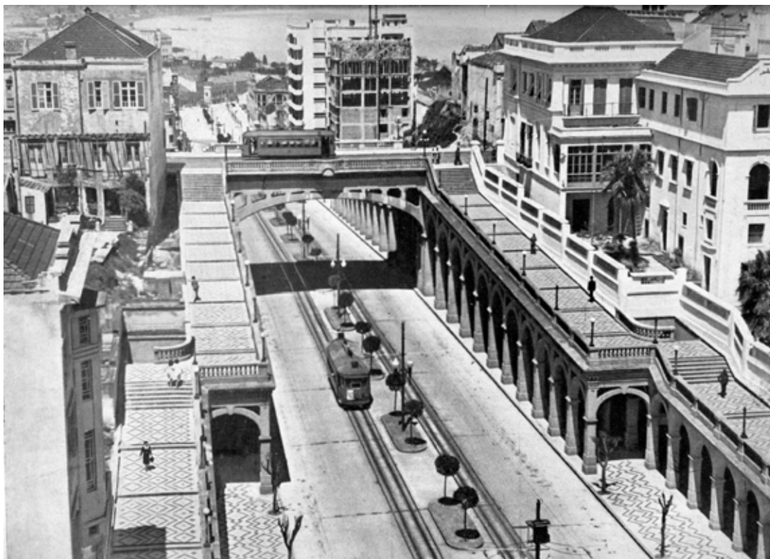
Imagem 63 – O viaduto Otávio Rocha, Porto Alegre (1928) – Manoel Itaqui. Fonte: PREFEITURA MUNICIPAL DE PORTO ALEGRE. Porto Alegre : retrato de uma cidade 1940. Brasil, Porto Alegre: Livraria do Globo, 1940.
