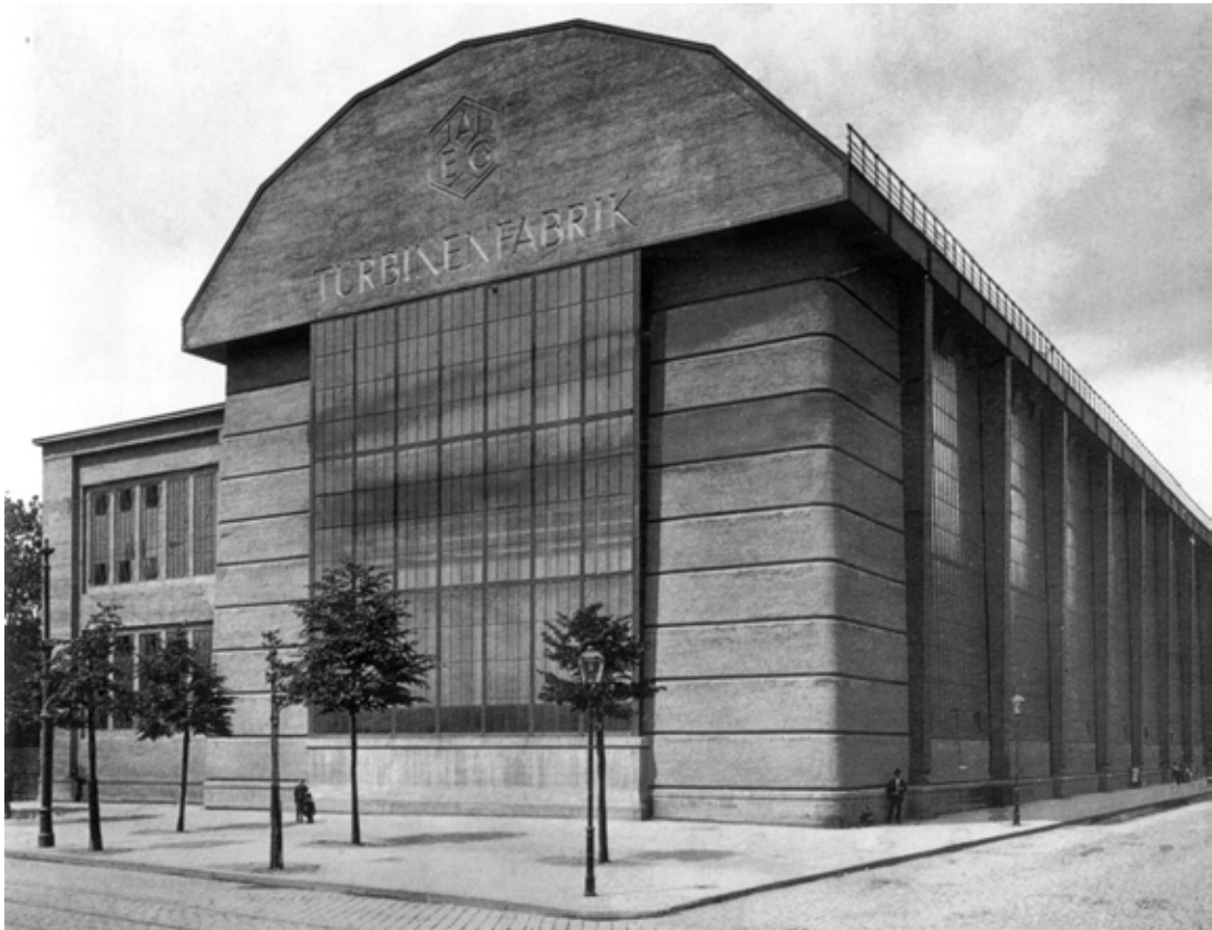
Imagem 08 – Fábrica de Turbinas AEG, Berlim (1908-1909) – Peter Behrens. Fonte: KHAN, Hasan-Uddin. Estilo Internacional: arquitetura moderna de 1925 a 1965. Alemanha, Köln: Taschen, 1999, p.15.
