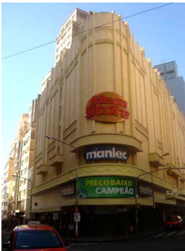
Imagem 139 – Edifício Comendador Chaves – situação atual, Porto Alegre (1933) – Saul Macchiavello e Antonio Rubio. Fonte: Foto do Autor (2010).
