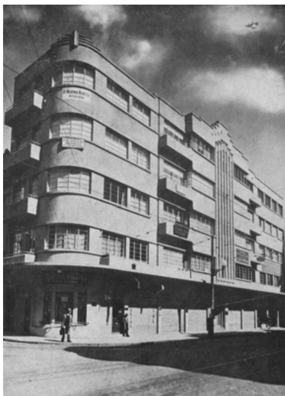
Imagem 71 – Edifício Palmeiro, Porto Alegre (1934) – Monteiro Neto. Fonte: RECORDAÇÕES DE PORTO ALEGRE. Brasil, Porto Alegre: Globo, 1935.
