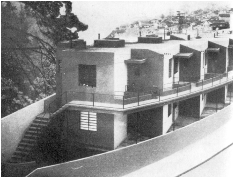
Imagem 19 – Apartamentos proletários, São Paulo (1931-1933) – Lúcio Costa e Gregori Warchavchik. Fonte: CAVALCANTI, Lauro. Guia de Arquitetura 1928 – 1960 . Brasil, Rio de Janeiro: Aeroplano, 2001, p.180.
