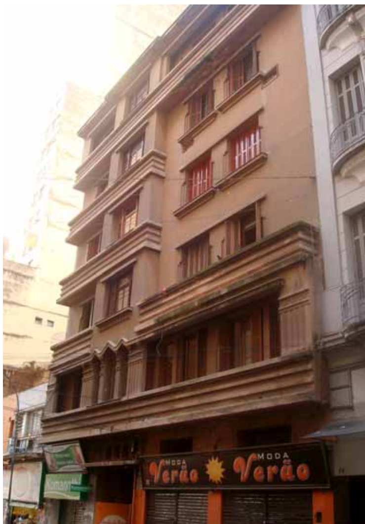
Imagem 156 – Edifício Paulino Chaves Barcellos – situação atual, Porto Alegre (1934) – Saul Macchiavello e Antonio Rubio. Fonte: Foto do Autor (2010).
