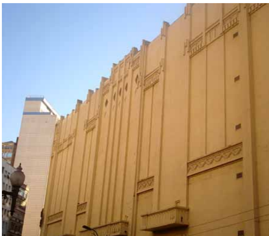
Imagem 140 – Edifício Comendador Chaves – situação atual, Porto Alegre (1933) – Saul Macchiavello e Antonio Rubio. Fonte: Foto do Autor (2010).
