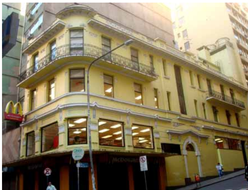
Imagem 119 – Edifício Arturo Jamardo e Irmãos – situação atual, Porto Alegre (1932) – Saul Macchiavello e Antonio Rubio. Fonte: Foto do Autor (2010).
