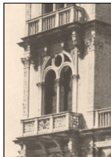
Figura 44 - Detalhe das janelas duplas sob mesmo arco e abertura circular no tímpano: Villino Zaglia, Lido/Veneza, início do Século XX.
