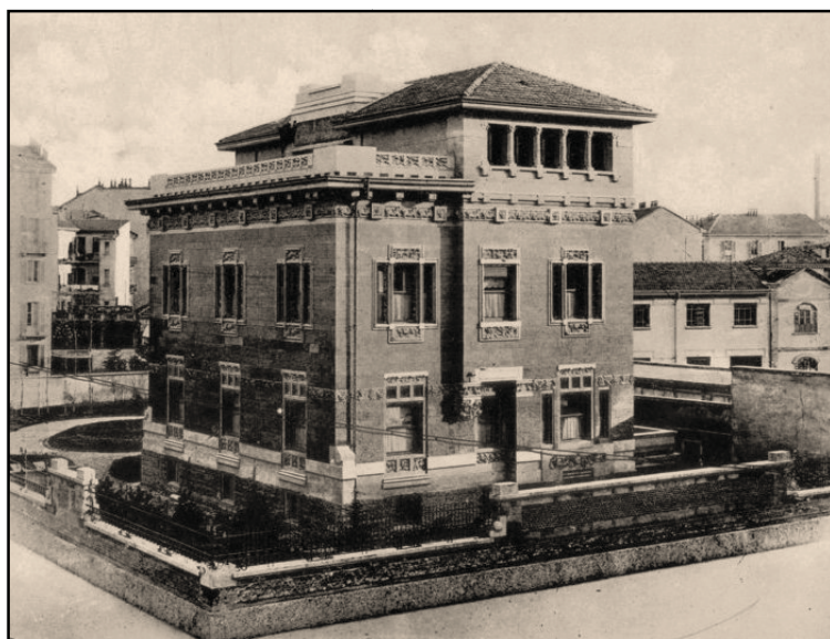
Figura 182 - Palazzina Angelo Salmoiraghi, de Giuseppe Sommaruga: plantas baixas e foto do exterior (da esquerda para a direita e de cima para baixo: porão, pavimento 1, pavimento 2 e pavimento 3, com terraço; embaixo, foto da parte posterior da edificação). Fonte: Desenhos das plantas de Gustavo Longaray Moraga a partir de SOMMARUGA, Giuseppe. L'architettura di Giuseppe Sommaruga . Milão: Preiss & Bestetti, s.d, p.25.
