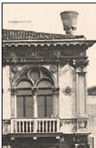
Figura 43 - Detalhe das janelas duplas sob mesmo arco e abertura circular no tímpano: Palazzo Corner-Spinelli, Veneza, fins do Século XV.
