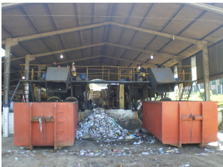
Estrutura de triagem
