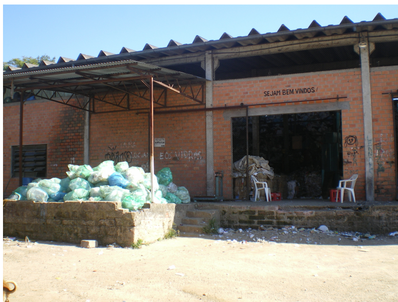
Galpão 1 – Triagem resíduos secos
