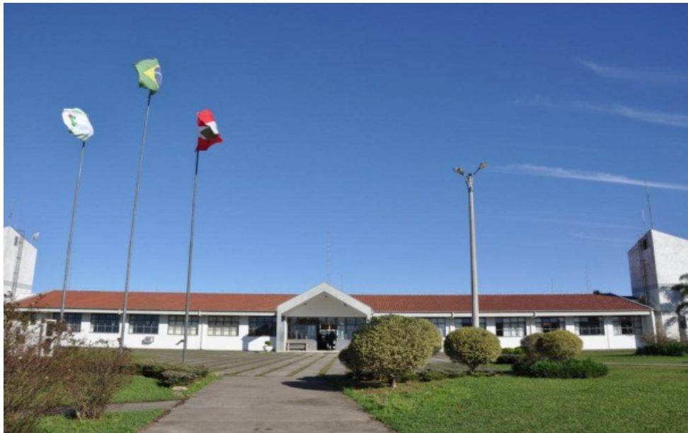
Figura 2 – Prédio Administrativo da Sede Agrária do Instituto Federal Catarinense – Campus Rio do Sul
