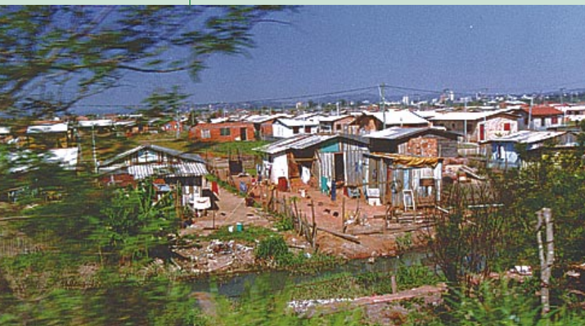
Favela: falta de planejamento urbano
