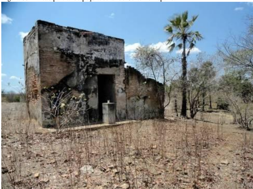
Figura 80 – Visão parcial do poço tubular do Curtume Repuxo.
