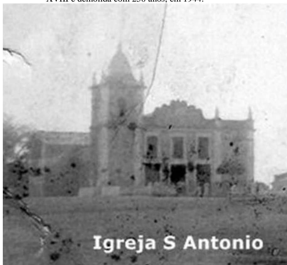
Figura 85 – Primeira Igreja de Santo Antonio, que foi construída no século XVIII e demolida com 250 anos, em 1944.
