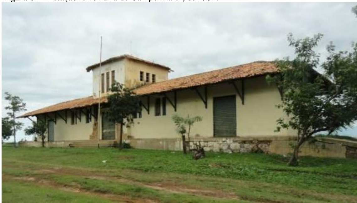
Figura 81 – Estação ferroviária de Campo Maior, de 1952.
