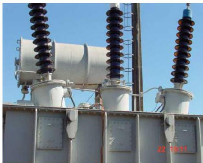
Figura 3.9 – Buchas de um transformador trifásico de alta tensão
