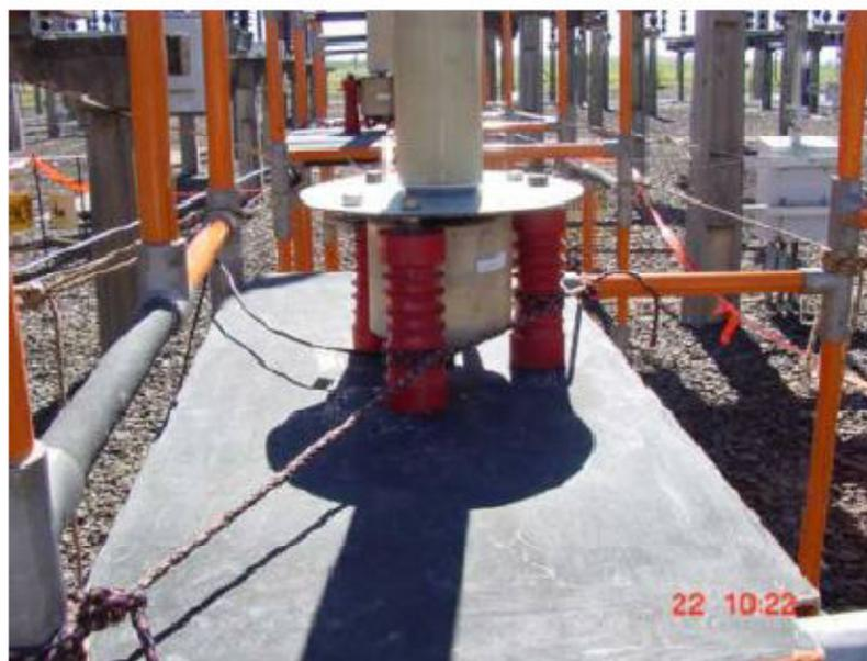
Figura 3.7 – Detalhe da unidade capacitiva de baixa tensão
