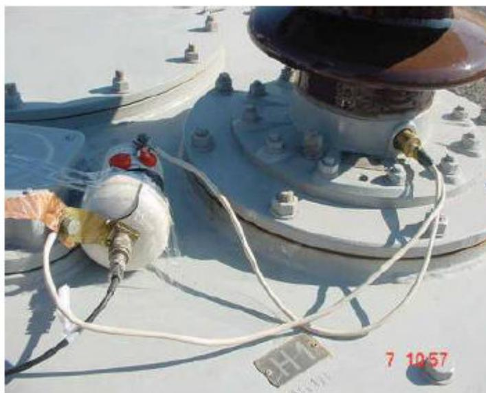
Figura 3.10 – Detalhe de unidade capacitiva de baixa tensão conectada ao *tap* capacitivo da bucha
