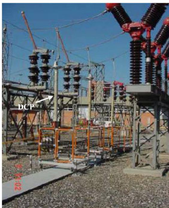
Figura 3.6 – Três unidades de Divisor Capacitivo de Potencial
