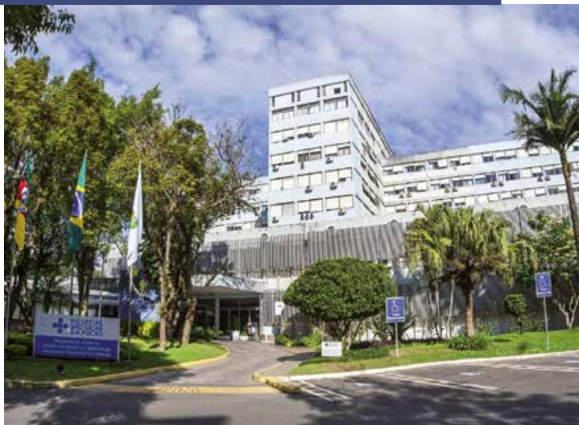
HSL no final da obra, em abril de 1976, seis meses antes de inaugurar, e hoje
