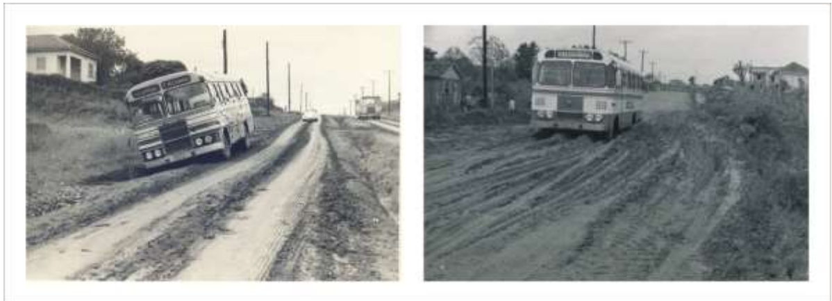
Figura 2: Problemas de infraestrutura
