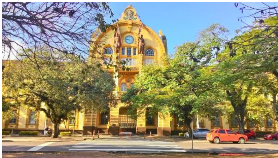
Figura 2: Fachada do Colégio Militar de Porto Alegre.
