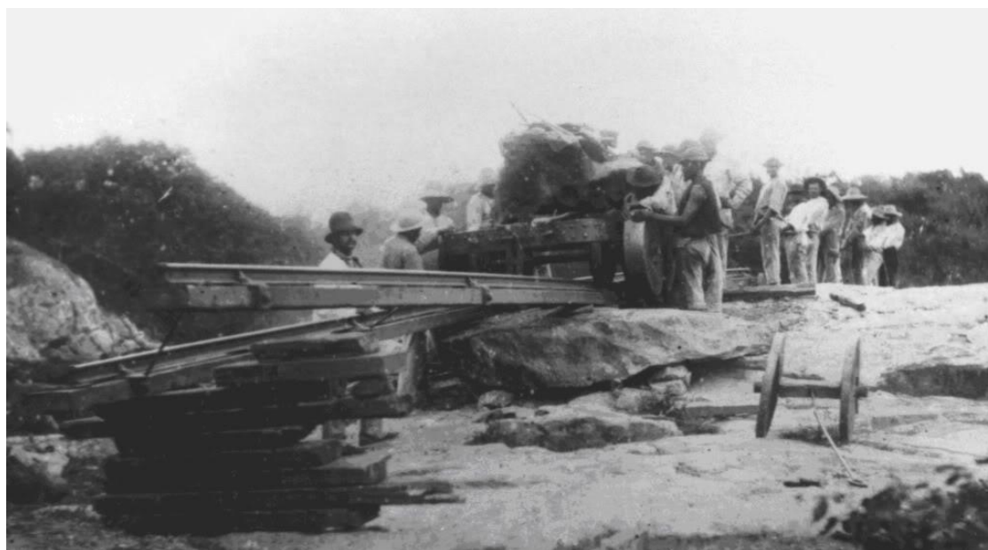
Figura 4 – Carreta em movimento sobre os trilhos
