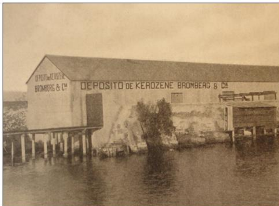
Figura 31: Depósito de querosene da Bromberg & Cia. em Rio Grande
