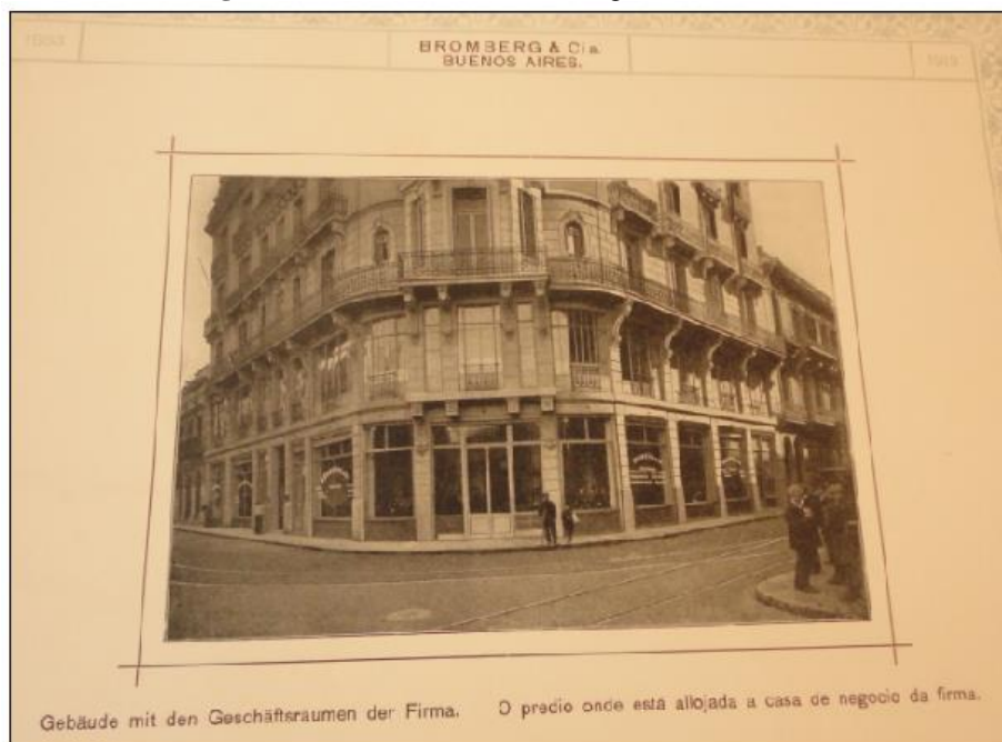
Figura 27: Sede da firma Bromberg em Buenos Aires
