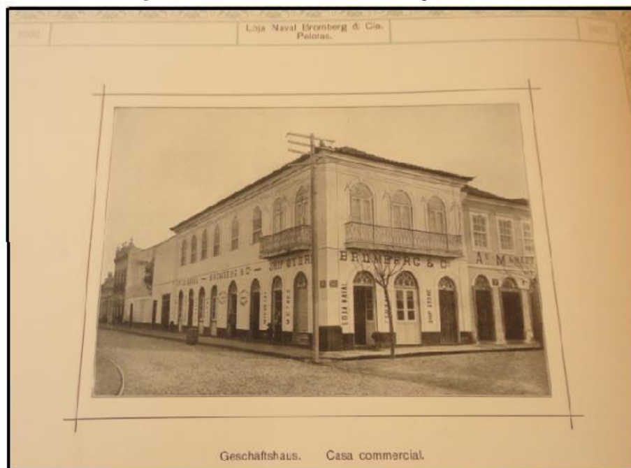
Figura 33: Casa comercial da Bromberg em Pelotas.
