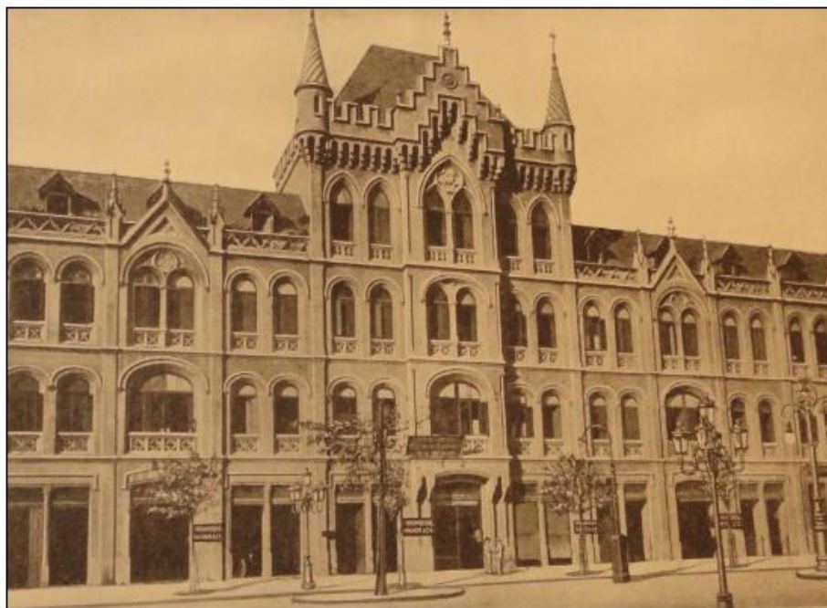
Figura 38: prédio da filial da Bromberg/Rio de Janeiro
