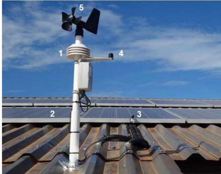
Figura 3.10. Sensores do sistema de monitoramento: 1 - sensor de temperatura ambiente, 2 - sensor de temperatura dos módulos fotovoltaicos (colado na face posterior de um dos módulos fotovoltaicos, não mostrado na figura), 3 – sensor de irradiância no plano dos módulos fotovoltaicos, 4 – irradiância global (horizontal) e 5 – anemômetro para velocidade e direção do vento.
