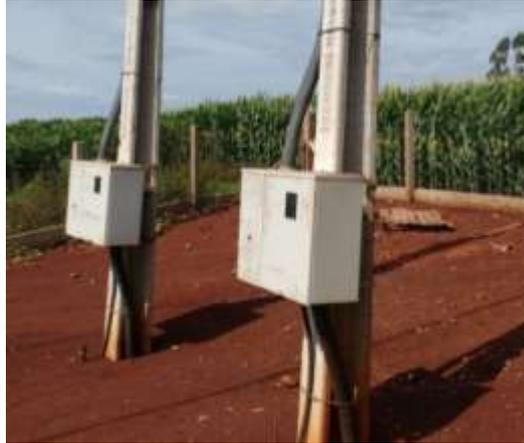
Figura 3.6. Entradas de serviço de energia elétrica da propriedade rural associada da cooperativa C.Vale, foto obtida antes da instalação do sistema FV.
