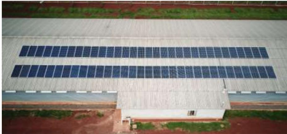
Figura 4.9. Módulos fotovoltaicos instalados na propriedade cooperativa da C.Vale, em Assis Chateaubriand/PR.
