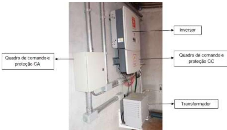
Figura 4.10. Equipamentos do sistema FV instalados na área de serviço da propriedade cooperativa da C.Vale.
