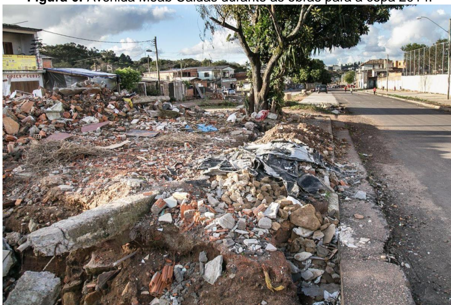
Figura 6: Avenida Moab Caldas durante as obras para a copa 2014.
