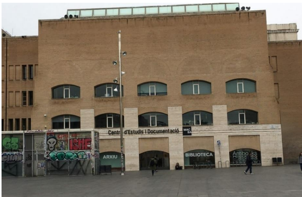
Figura 1 - Fachada do prédio do Centre d'Estudis i Documentació do MACBA
