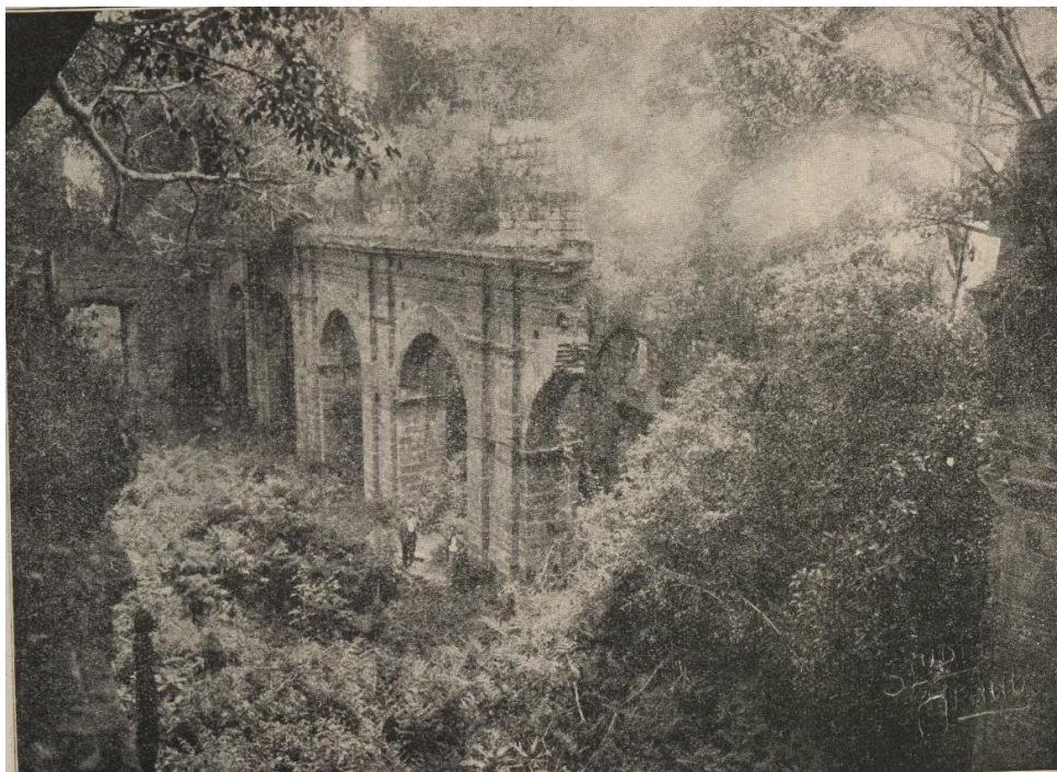
Figura 29 - Fotografia do interior da Igreja tomada pela vegetação
