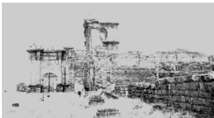
Figura 17 - Antes do processo de estabilização da frontaria da Igreja.
