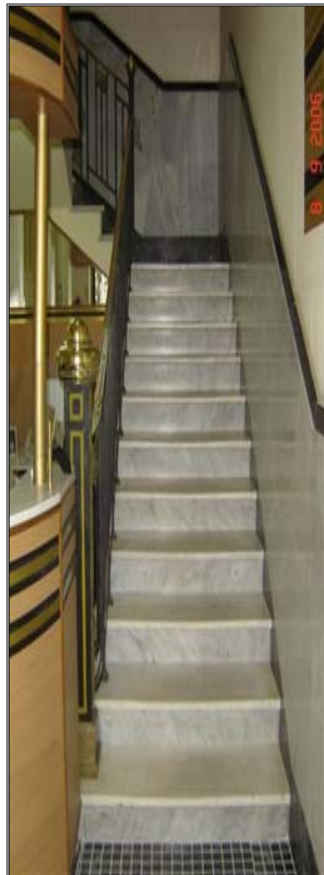
Figura 4 - Escadaria de acesso ao 2º andar da Auditoria Militar
