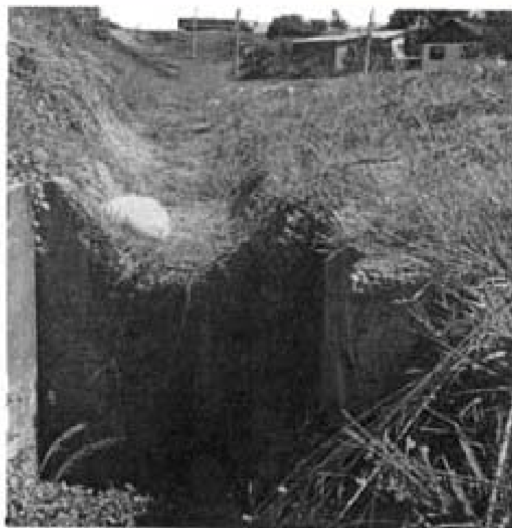
Bueiro sem tampa mede aproximadamente dois por dois metros de diâmetro por cinco de profundidade
