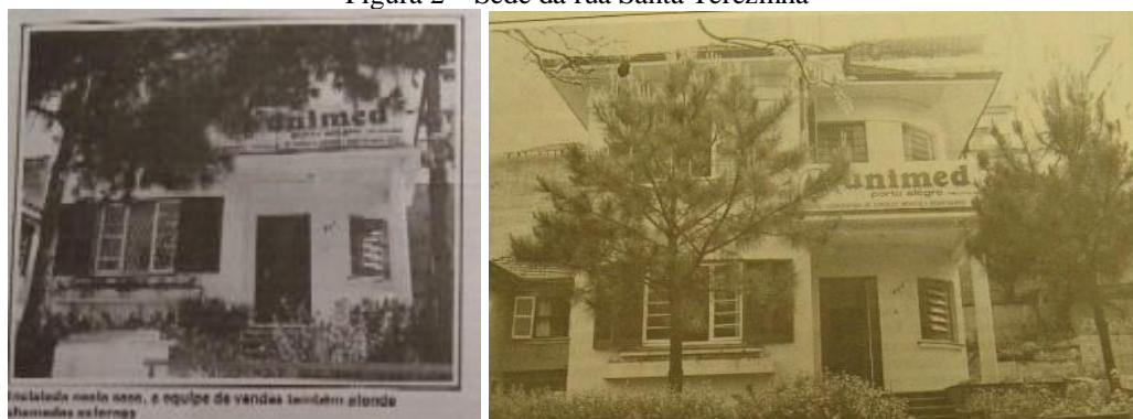
Figura 2 – Sede da rua Santa Terezinha
