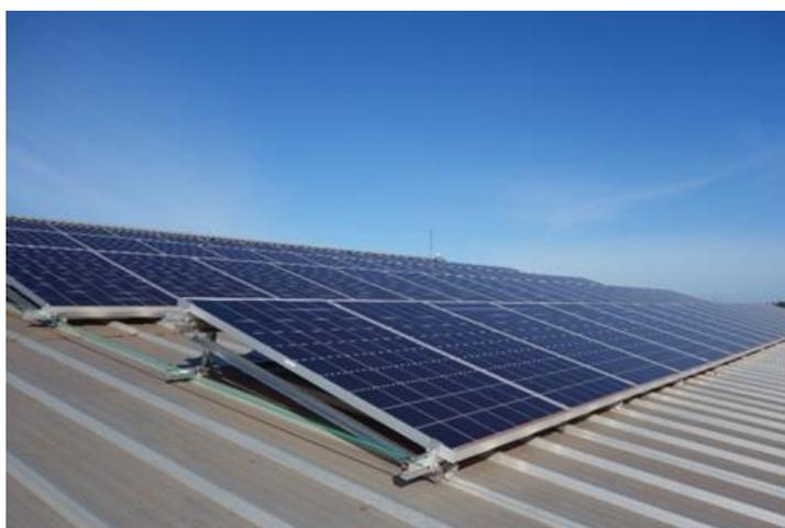
Figura 16: Ilustração da separação dos módulos fotovoltaicos em relação ao telhado do sistema instalado no galpão na propriedade rural associada da cooperativas LAR.
