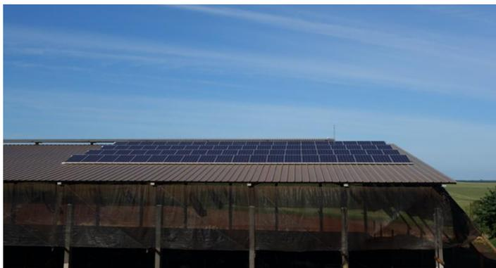
Figura 15: Arranjo fotovoltaico do sistema instalado no galpão de estadia das vacas produtoras de leite na propriedade rural associada da cooperativas LAR.
