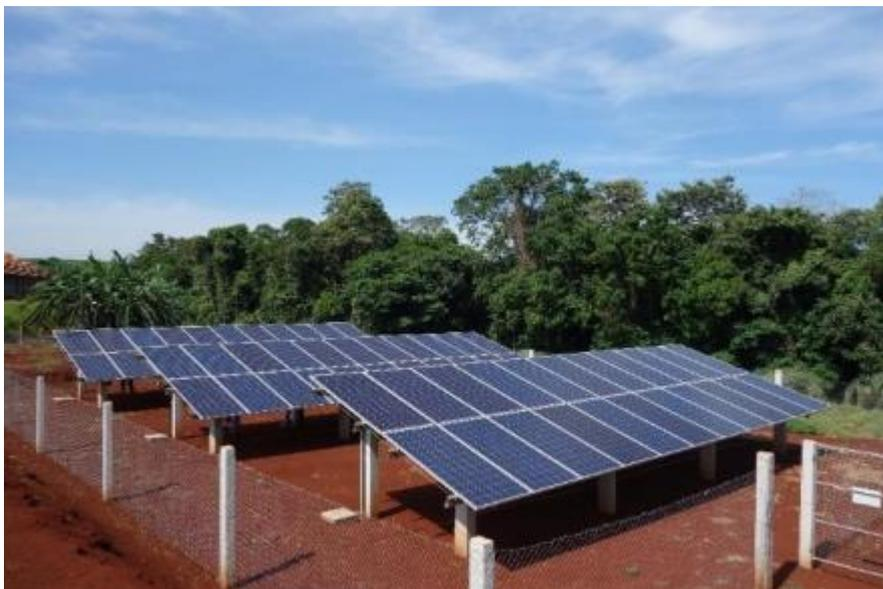
Figura 17: Arranjo fotovoltaico do sistema instalado em solo na propriedade rural associada da cooperativa COPACOL.
