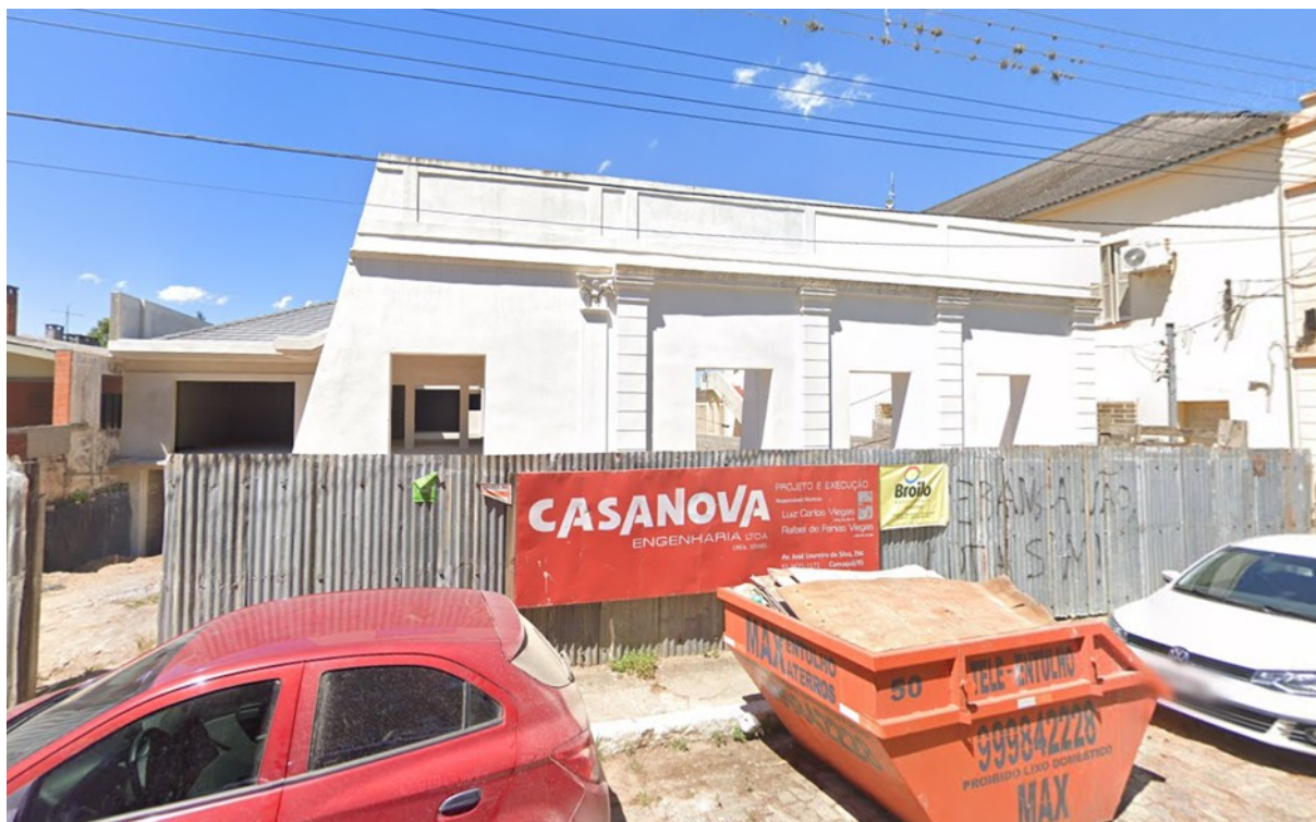
Imagem 20 – Conjunto de Casas após intervenção e descaracterização de sua arquitetura
