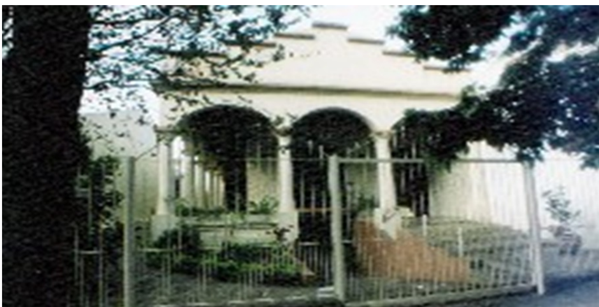
Imagem 18 – Casa de José Bukowski, exemplar urbano de arquitetura. ANEXO X, Camaquã
