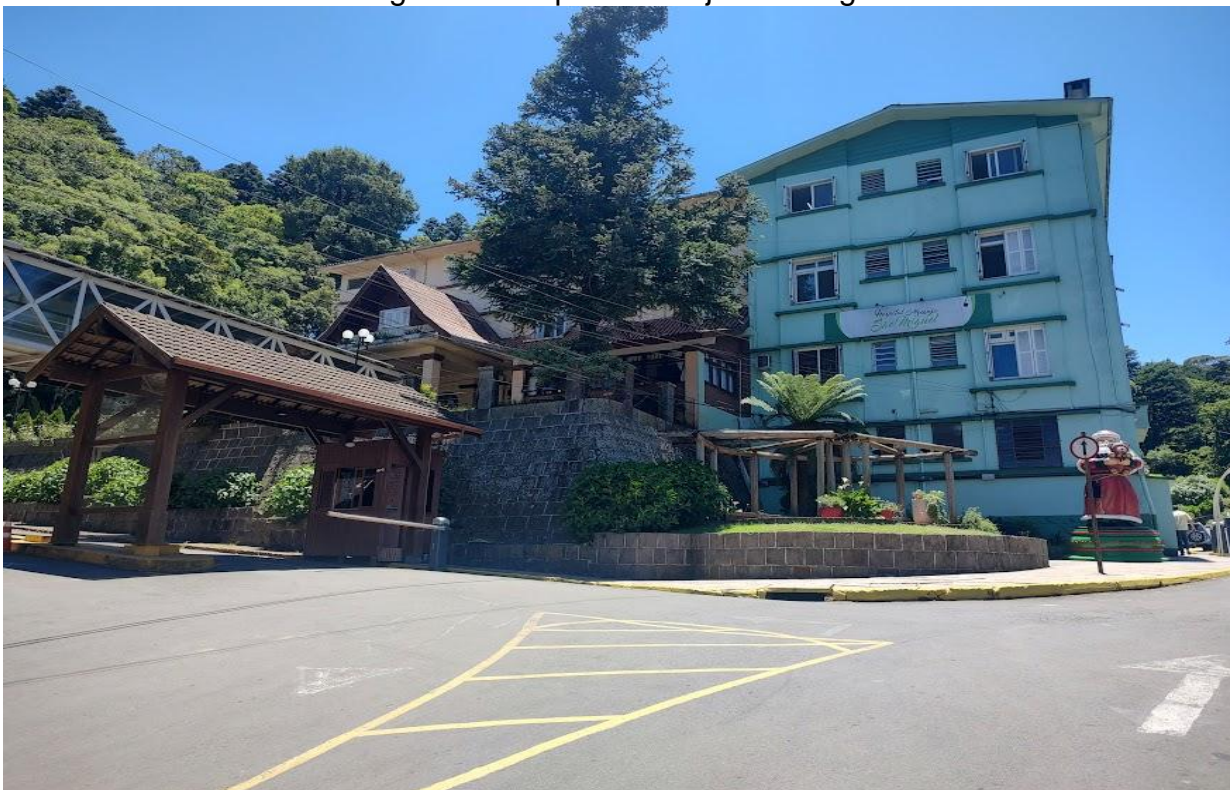
Figura 8. Hospital Arcanjo São Miguel
