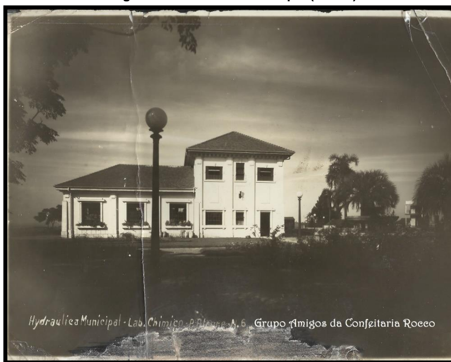
Figura 42: Hidráulica Municipal (DMAE)
