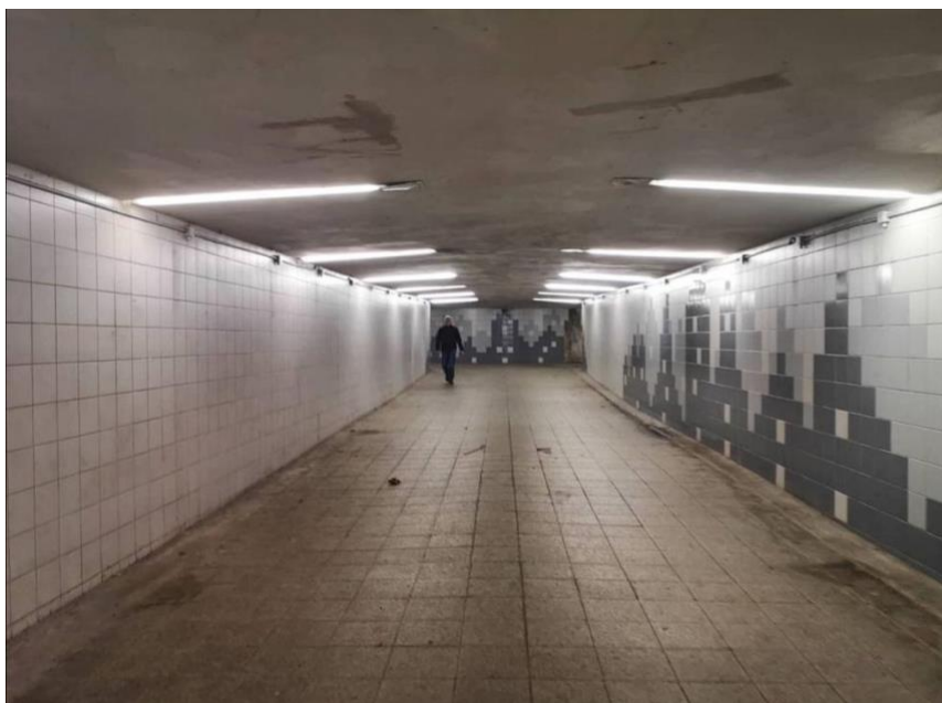
Figura 12 - Passagens subterrâneas de Talin
