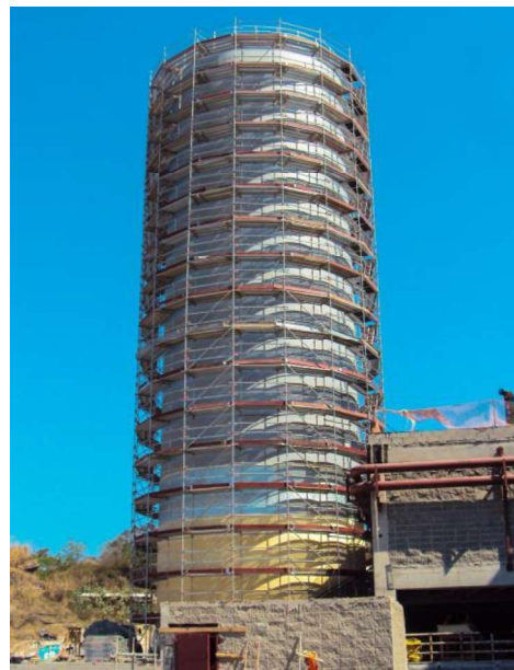
Figura 6: Utilização de andaime fachadeiro tipo multidirecional
