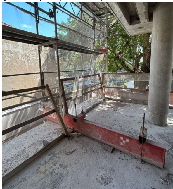
Figura 20: Implantação em balanço do andaime fachadeiro
