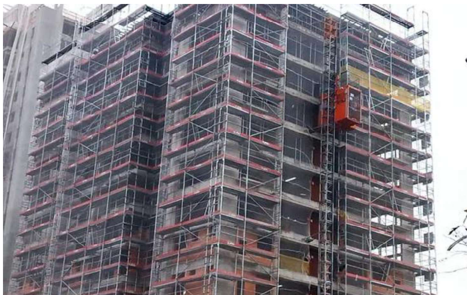
Figura 1 - Edificação utilizando andaime fachadeiro
