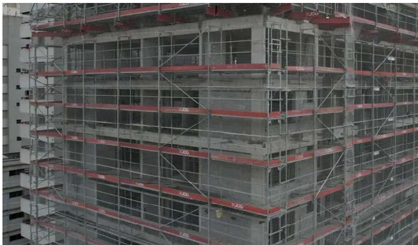
Figura 3 - Utilização em obra de andaime fachadeiro do tipo modular
