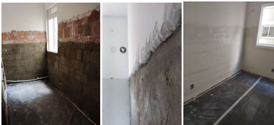
Figura 18: Aplicação de argamassa polimérica com espessura entre 2-5mm por demão, seguida pela finalização de superfície
