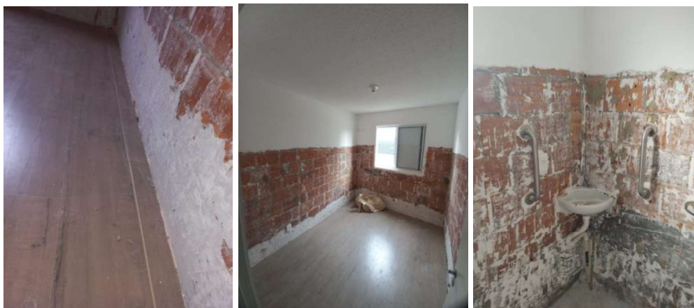
Figura 17: Execução das medidas corretivas nos apartamentos térreos da Fase 1- remoção do reboco para recebimento de tratativa com argamassa polimérica
