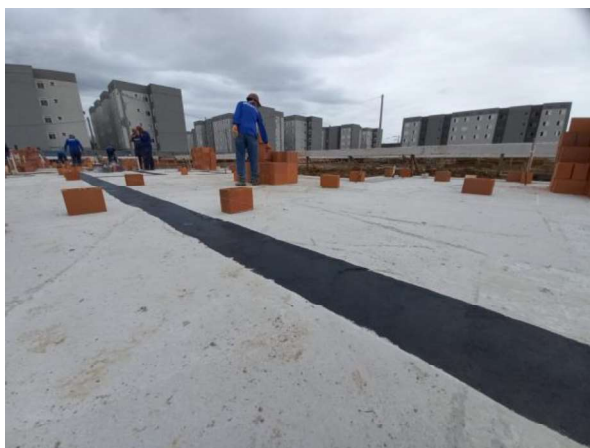
Figura 21: Etapa do empreendimento em estudo ainda em construção e sem impermeabilização no radier
