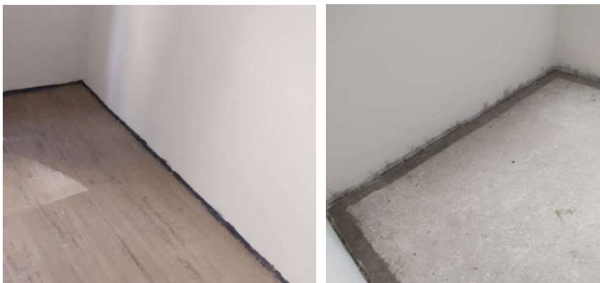
Figura 20: Paredes com acabamento
