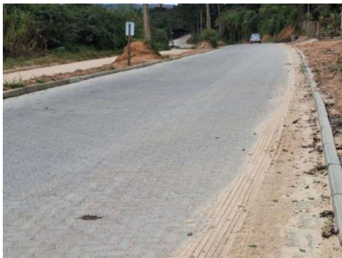
Apêndice A 5: Afundamentos na via após a conclusão
