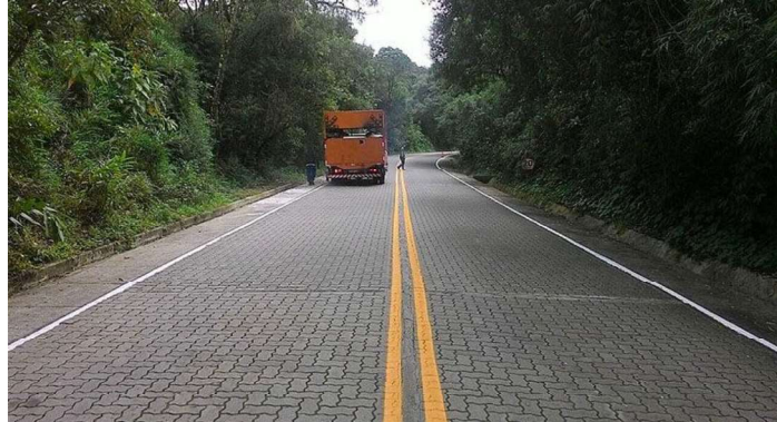
Figura 2: Via pavimentada com blocos intertravados
