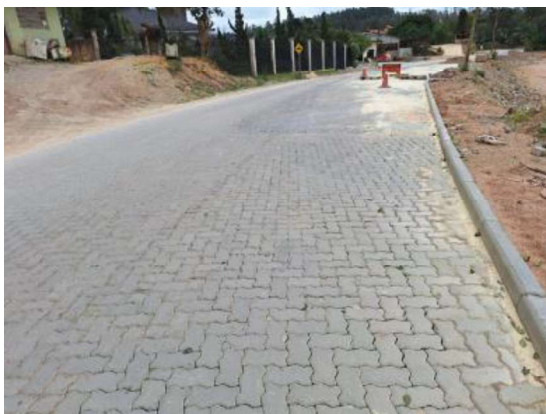
Figura 21: Pavimentação executada no modelo espinha de peixe
