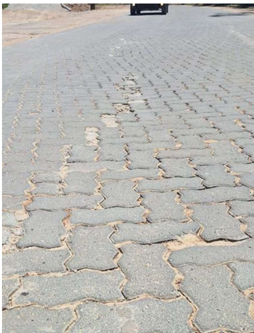
Apêndice A 8: Detalhe da movimentação dos blocos, falta contenção e juntas largas
