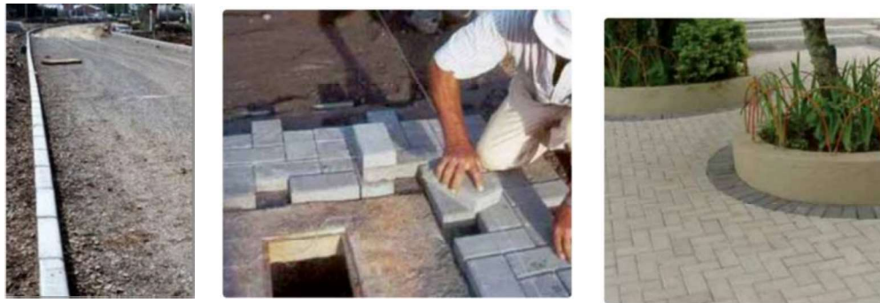
Figura 8: Contenção lateral externa (à esquerda) e interna (figura central e direita)
