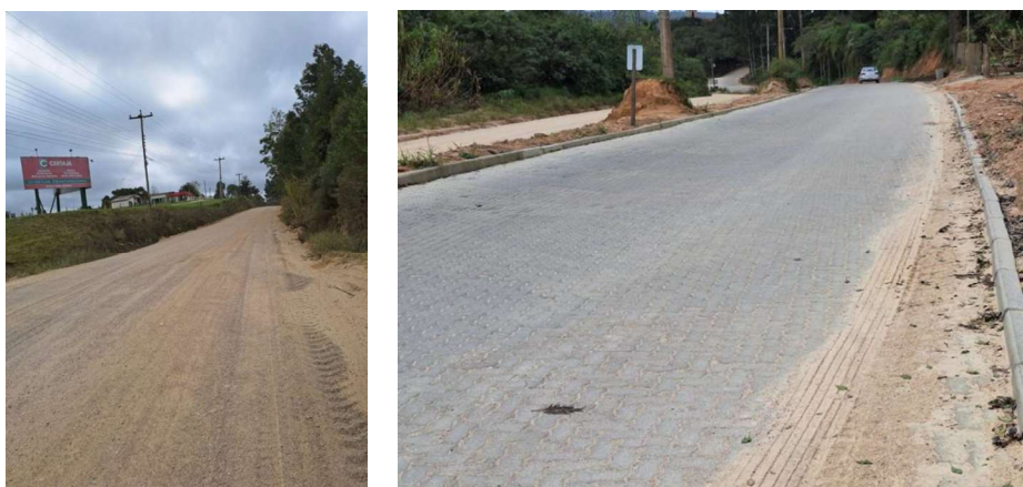
Figura 16: Parte da estrada ainda não pavimentada e trecho pavimentado
