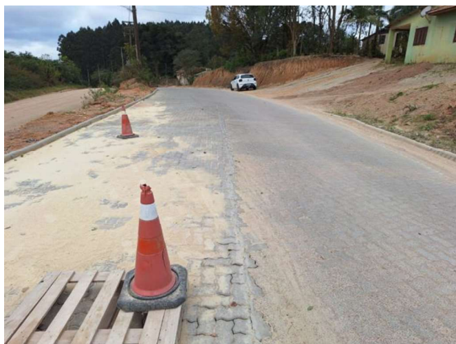
Apêndice A 11: proteção provisória do trecho em manutenção
