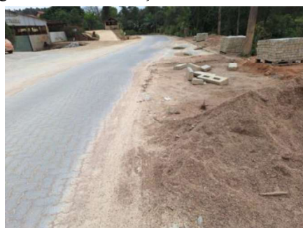
Figura 23: Pavimentação com blocos intertravados
