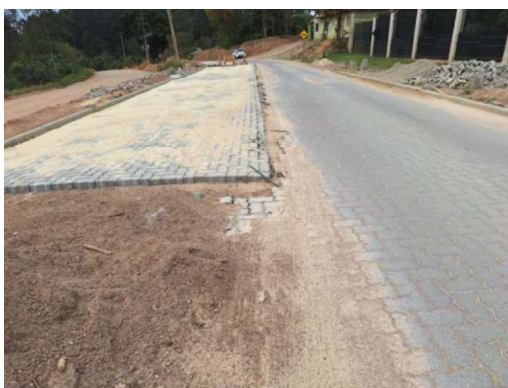
Apêndice A 7: Manutenção após entrega da pavimentação
