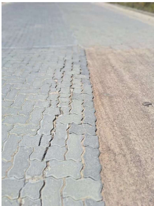
Apêndice A 8: Detalhe da movimentação dos blocos, falta contenção e juntas largas
