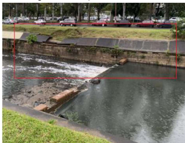
Figura 1: modulação danificada
