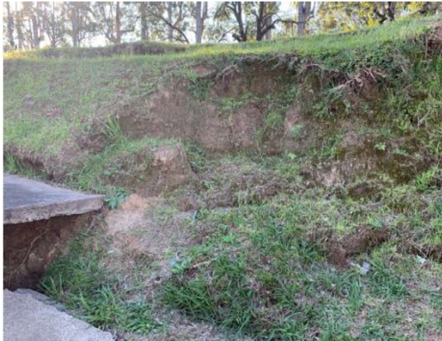
Figura 15: Imagem para mostrar a dimensão da ruptura do talude no local
