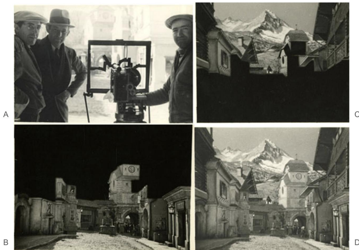
Figura 7 – Câmera com vidro pintado à sua frente (A), matte shot (B), matte painting (C) e composição final (D)
