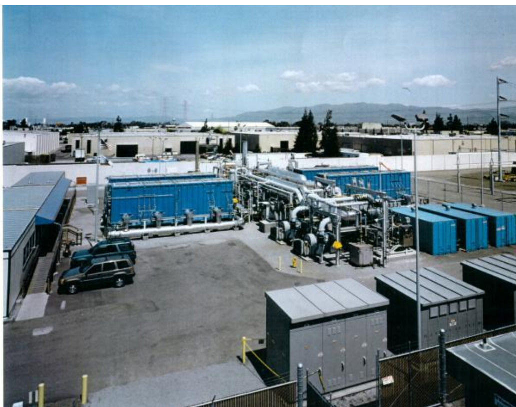
Figura 1.12: Instalações do Santa Clara Demonstration Project . Fonte: [14]
