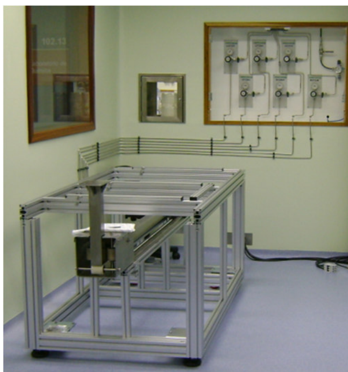
Figura 5.37. Extensão da tubulação de gases para interligar a saída do painel à entrada do armário de gases do forno. À frente, parte inferior da estrutura durante a montagem.
