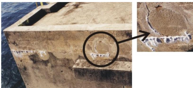
**Figura 2.1 – Lixiviação do concreto em zona marinha, onde se pode observar o produto branco de carbonato de cálcio (CaCO<sub>3</sub>) no detalhe ampliado (GENTIL, 2003).**
