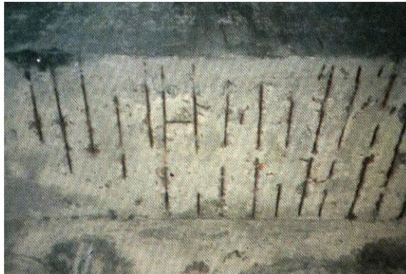
**Figura 3.2 - Corrosão generalizada da armadura de uma laje devido ao ataque por cloro, com desagregação do concreto de cobertura (HELENE, 1988).**
