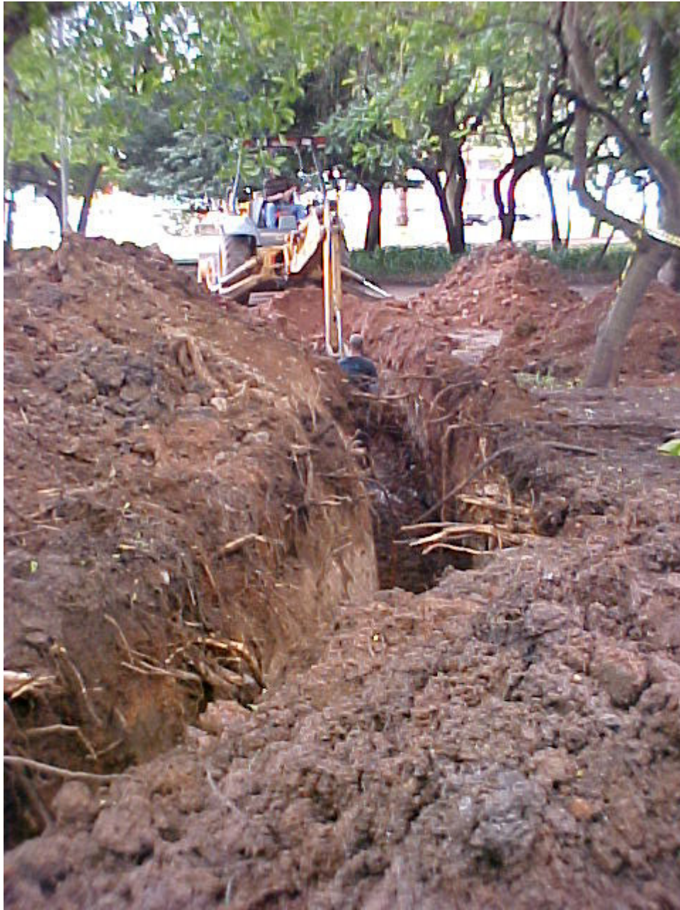
(Local: Parque da Redenção (RS. JA – 26). Processo de escavação, decorrente da obra de reparo na canalização realizada pelo DMAE, onde constatou-se a ocorrência de material arqueológico misturado ao sedimento que saía da vala Arquivo de imagens do setor de Arqueologia.).
