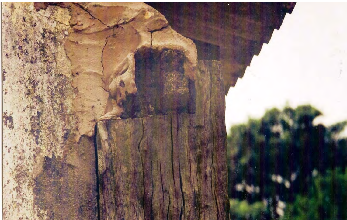
Figura 12: Reparo feito com cimento na busca de preservar a casa provisória da Estância Santa Eliza. Fonte: Acervo da autora (30/12/2002).
