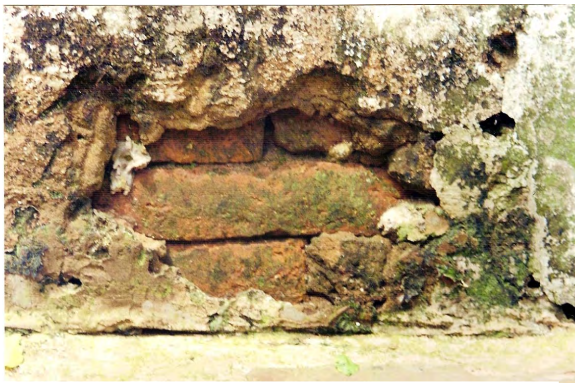
Figura 13: Detalhe da parede que evidencia o material construtivo empregado na casa provisória da Estância Santa Eliza. Fonte: Acervo da autora (30/12/2002).
