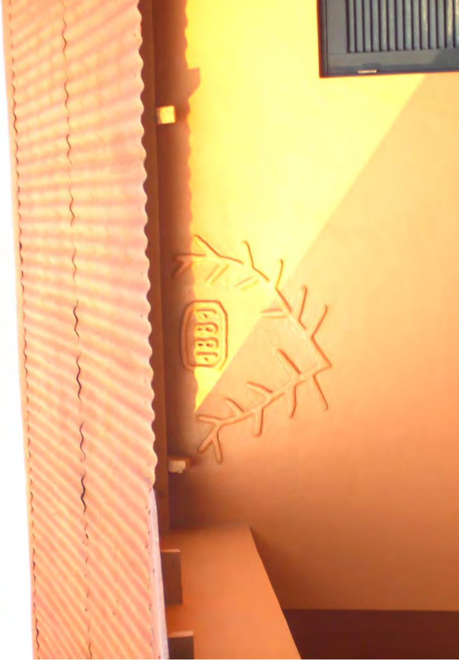
Figura 20: Detalhe da casa-sede da atual Fazenda Toropi. A marca preservada em sua parede registra o ano de sua construção, única evidência do século XIX mantida na fachada desta edificação. Fonte: Acervo da autora (25/08/2006).
